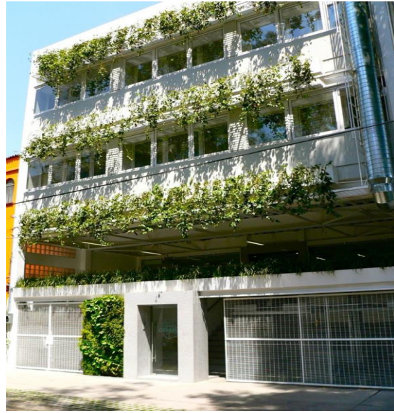
Imagen 6: Edificio M 16 después
