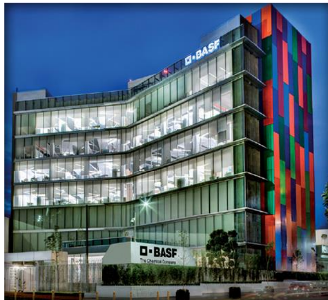
Imagen 7: BASF, México, D. F.
