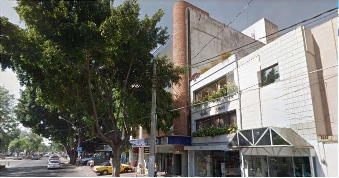
Imagen 11: Vista lateral del edificio
