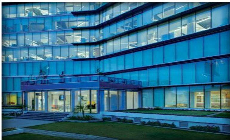
Imagen 8: BASF, México, D. F.
