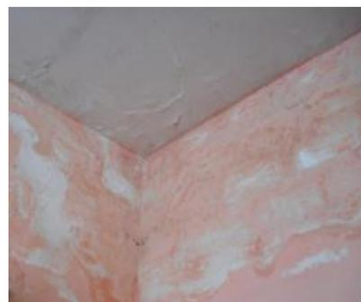
Fotografía 7. **Problemas de humedad en techos y muros**
