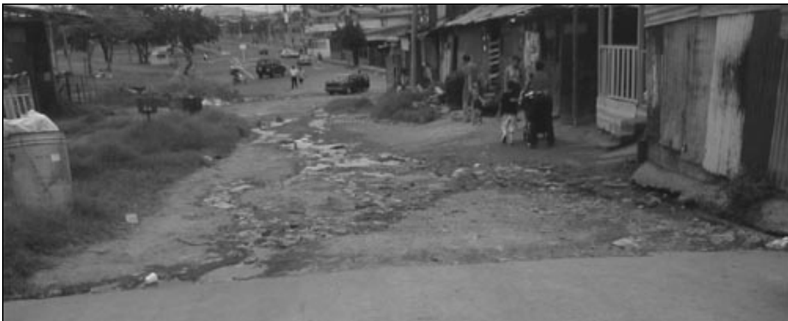
Algunas zonas permanecen en precario.
