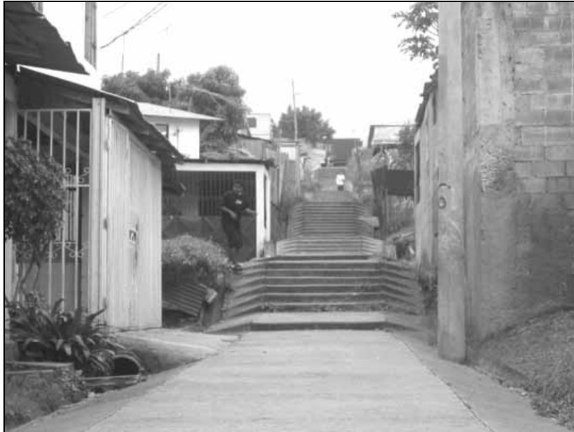
Las gradas. Vista hacia el sur
