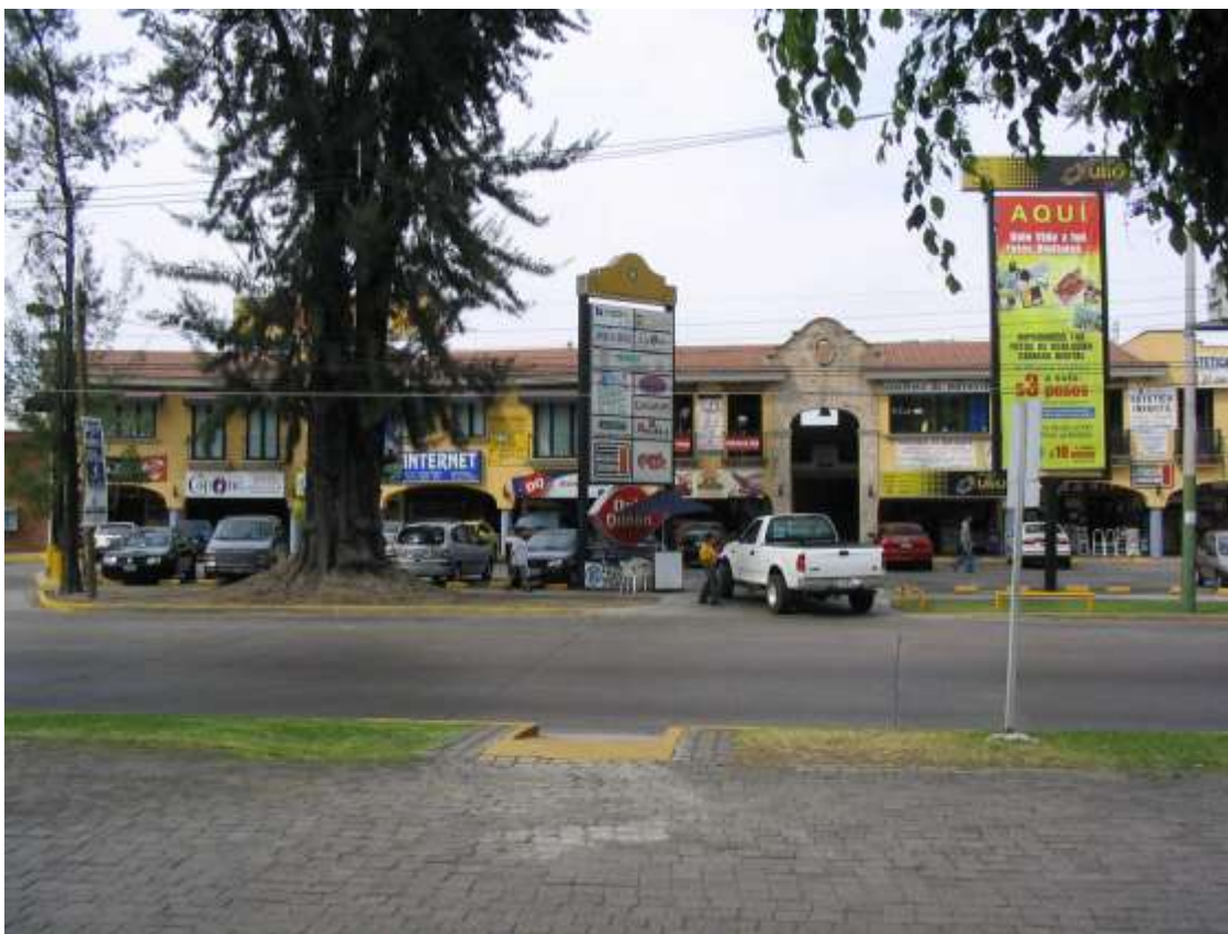
Centro comercial en Av. Guadalupe frente a la glorieta de Chapalita. El estilo arquitectónico es un intento de imitar lo regional, la transculturación de la zona es evidente en los anuncios de los establecimientos.
