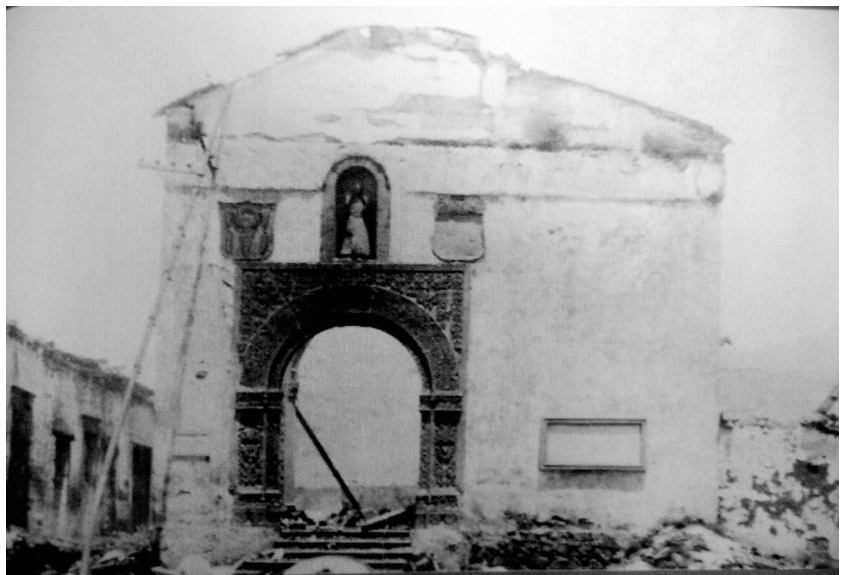
Fotografía 5: Reproducción de una fotografía tomada después del incendio de 1953. Se pueden ver los graves daños que causó y la pérdida de las cubiertas
