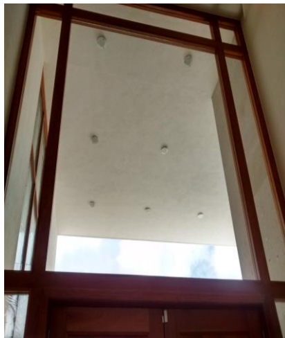
Techo en ingreso
