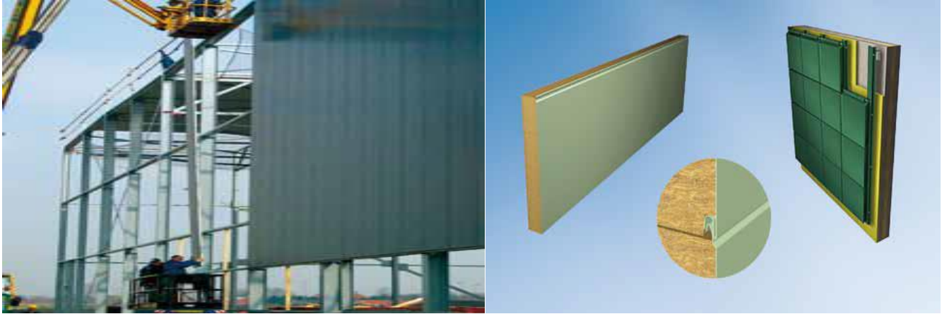
Ilustración 13 Detalle de envoltorio en muros. Fuente: http://sections.arcelormittal.com
