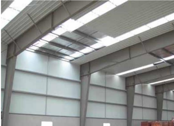
Ilustración 9 Sistema estructural y de envoltivo. Fuente: http://sections.arcelormittal.com
