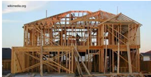
Figura 2. Vivienda con sistema de marcos en madera.
