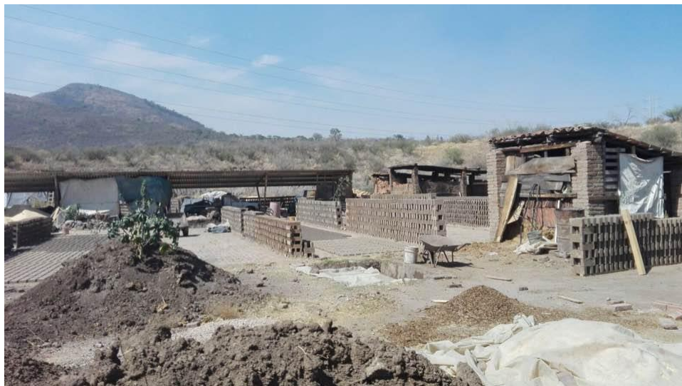
Fig. 14 Ladrillera de Don Leo en Tlajomulco de Zúñiga.
