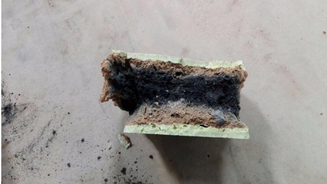
Fig. 19 Fragmento de ladrillo hecho in situ. Se observa coloración negra anormal en el centro.
