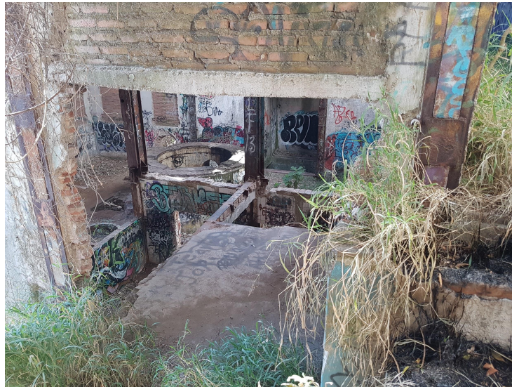
Ilustración 21. Interior actual Hidroeléctrica y Textiles. *Trabajo de campo Febrero 2017.
