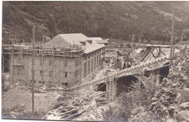
Ilustración SEQ Ilustración \* ARABIC 30. Construcción Central de Capdella. * Colección Postales antiguas de Cataluña.
