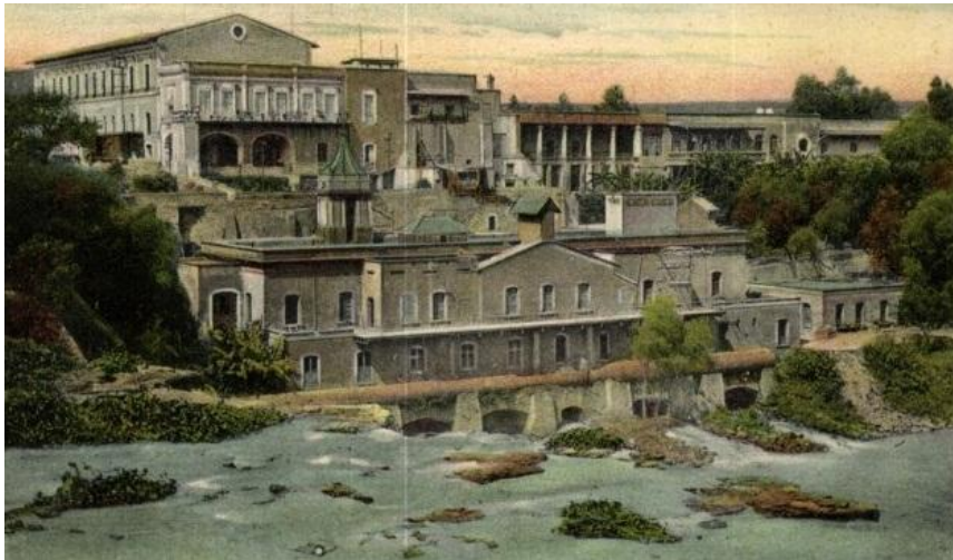
Ilustración SEQ Ilustración \* ARABIC 14. Fábrica de hilados e hidroeléctrica. * "cronología" de Pedroza R. O.
