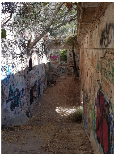
Ilustración 20. Interior actual Hidroeléctrica y Textiles. *Trabajo de campo Febrero 2017.
