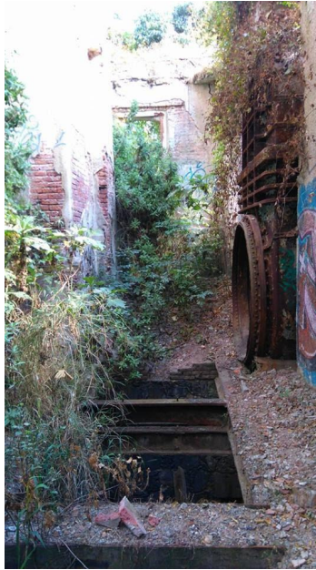
Ilustración 19. Interior actual Hidroeléctrica y Textiles. *Trabajo de campo Febrero 2017.
