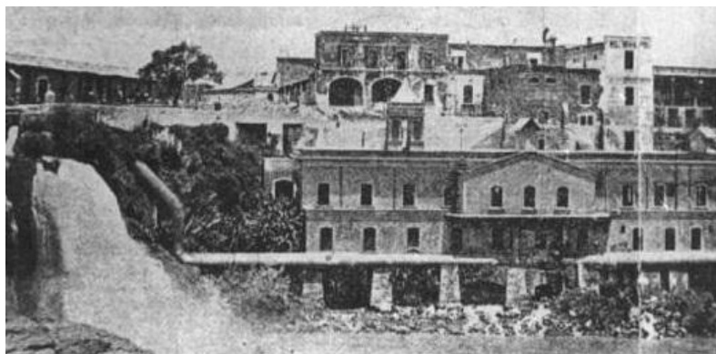
Ilustración 8. Planta hidroeléctrica y de hilados. * "Cronología" de Pedroza R.O.
