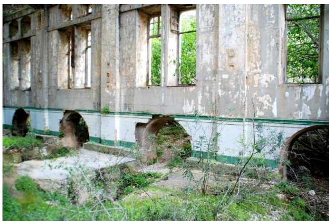
Ilustración SEQ Ilustración \* ARABIC 51. Sala de máquinas en ruinas. *Andamontes Blog.
