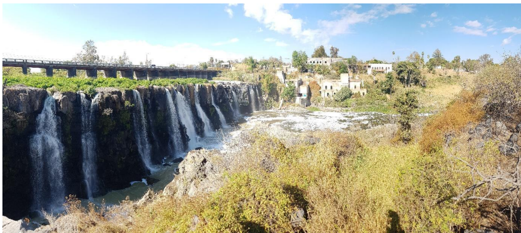
Ilustración 22. Caída de agua El Salto de Juanacatlán. *Trabajo de campo Febrero 2017.
