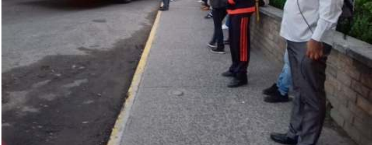
Ilustración 28. Muro perimetral en la plaza comercial.
