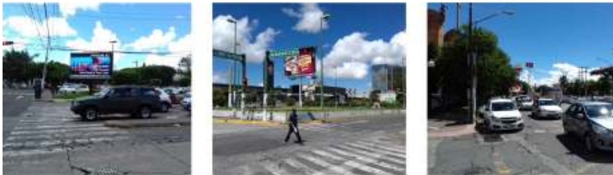
Ilustración 34. Calle y cruces peatonales que rodean a la plaza en mal estado.
