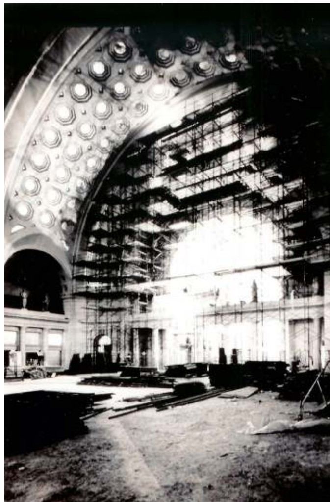
Ilustración 13. Construcción de Union Station.
