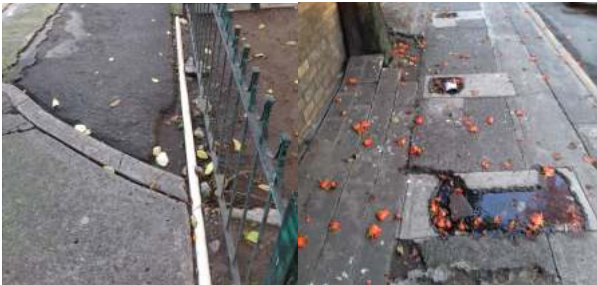
Ilustración 29. Estado actual de las banquetas.
