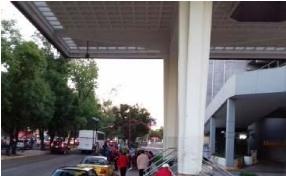
Ilustración 30. Techo en el área de espera transferencias.
