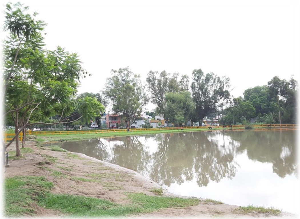
Fotografía 1. Vaso regulador dentro del PMG. Fuente: fotografía propia.
