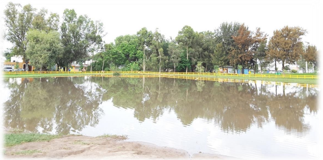
Fotografía 2. Vaso regulador dentro del PMG. Fuente: fotografía propia.
