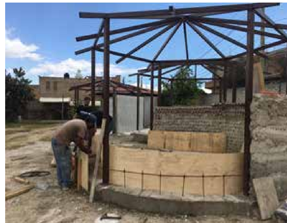
Imagen 41. Cimbrado y colado de bancas 2016. Foto por Carlos Estrada.
