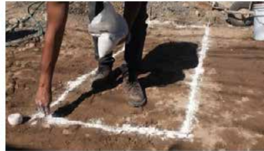
Imagen 88. Trazado con hilo y cal del perímetro de la cama. Foto por Carlos Estrada.
