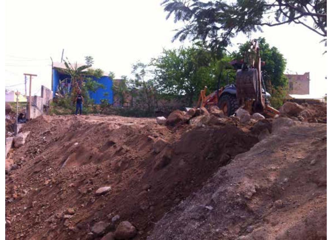
Imagen 26. Maquinaria rellenando socavón. Foto por Ricardo Riveros.
