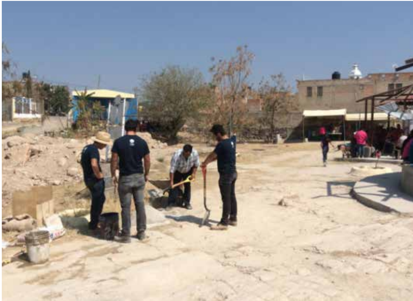
Imagen 47. Proceso de relleno. Foto por Carlos Estrada.
