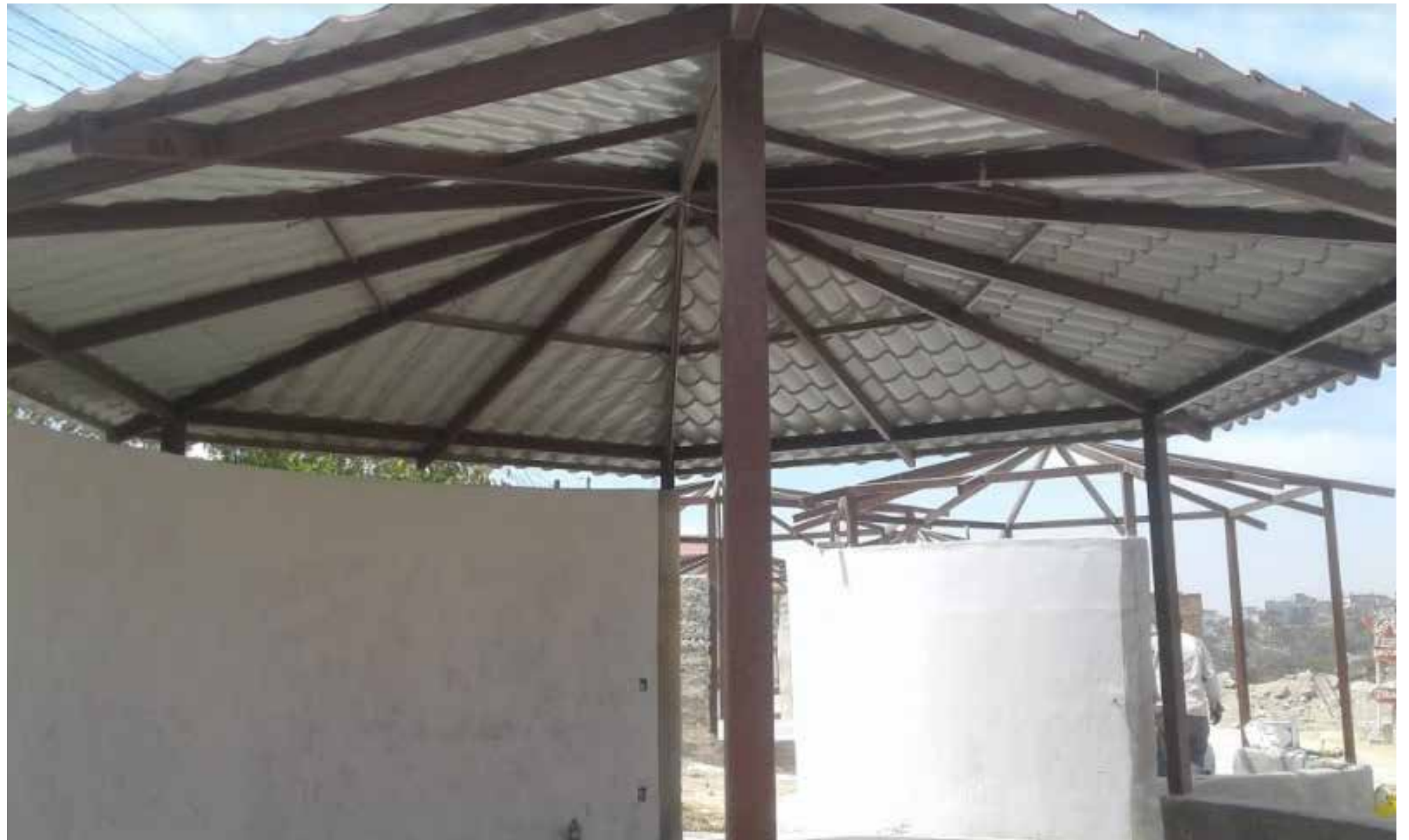
Imagen 43. Primer terraza con cubierta terminada. Foto por Carlos Estrada.
