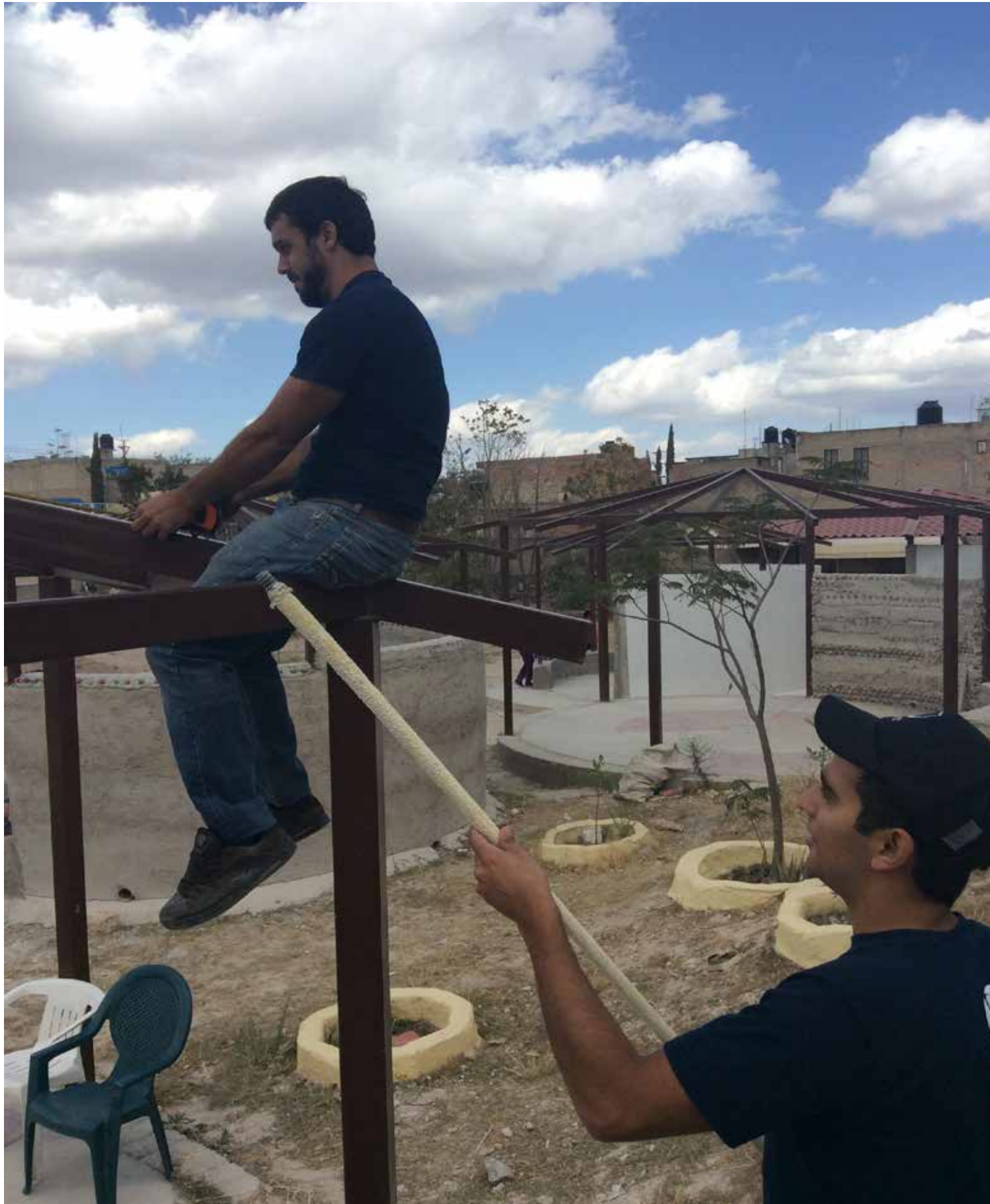
Imagen 29. Medición de techumbre - terrazas. Foto por Carlos,
