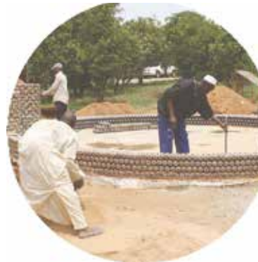
Diagrama 21. Sistema constructivo con botellas de PET rellenas de tierra.
