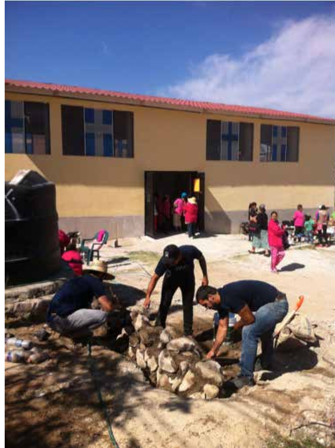
Imagen 48. Proceso de mamposteo. Foto por Carlos Estrada.
