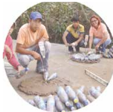
Diagrama 21. Sistema constructivo con botellas de PET rellenas de tierra.
