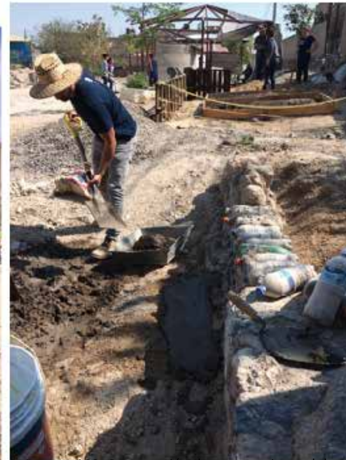
Imagen 102. Construcción de muro perimetral de mampostería en área de impartición de clase. Foto por Carlos Estrada.
