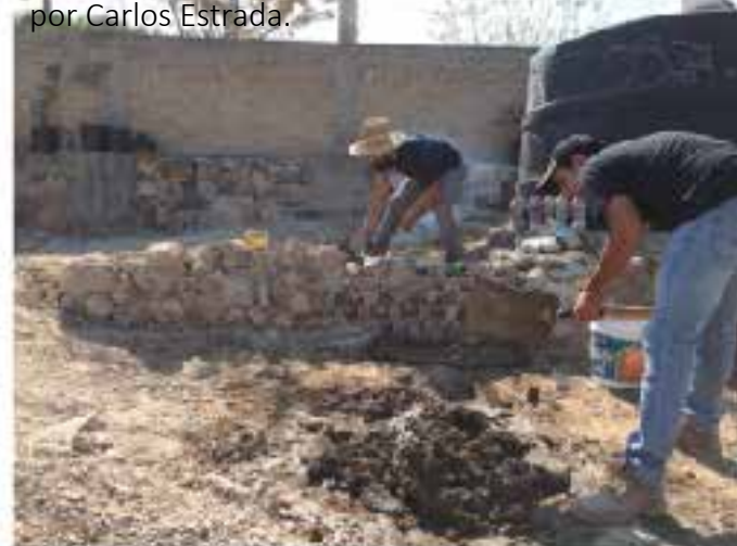
Imagen 103. Vista frontal de construcción de muro perimetral del área de clase. Foto por Carlos Estrada.
