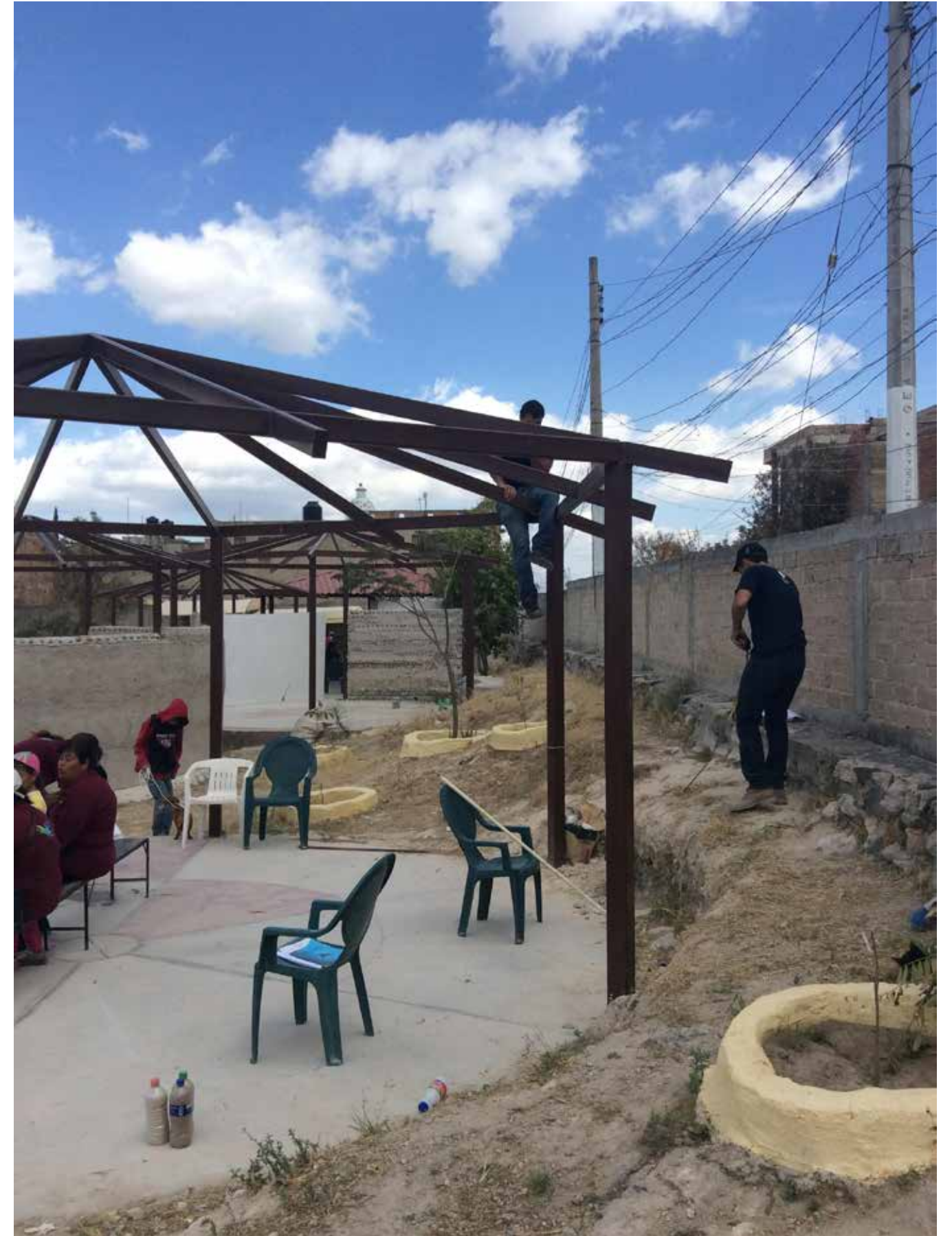
Imagen 30. Medición de techumbre - terrazas. Foto por Carlos Estrada.
