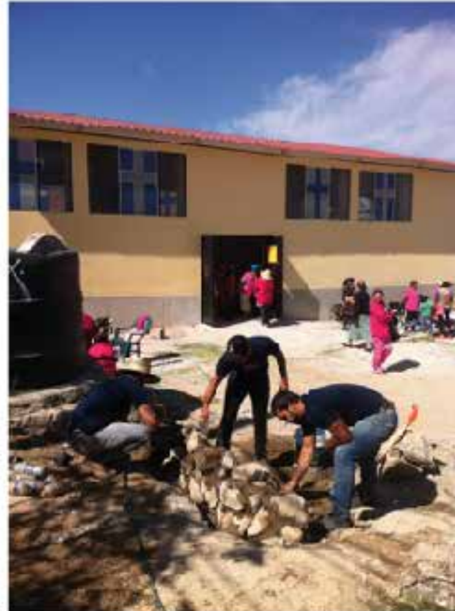
Imagen 101. Construcción de muro perimetral de mampostería en área de impartición de clase. Foto por Carlos Estrada.
