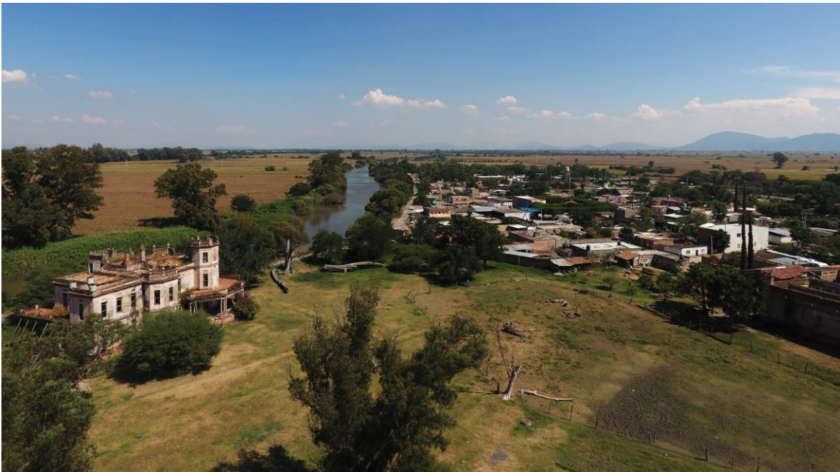
Fotografía Suroeste: Vista General del Terreno
