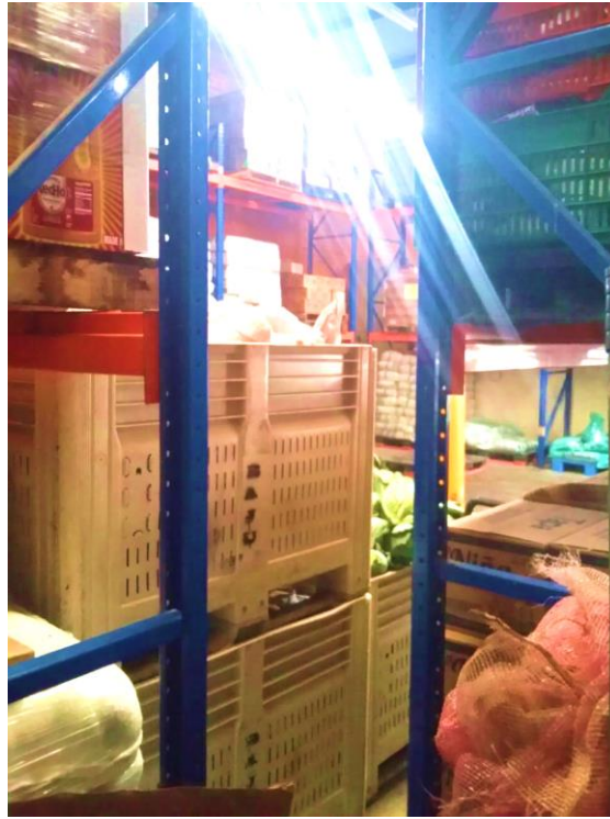
Imagen 7: Separación de racks del almacén 1.
