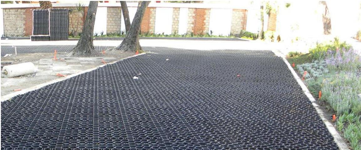
**Ilustración 55** Rejilla permeable Fuente: [Gravalock.com.mx](http://Gravalock.com.mx)
