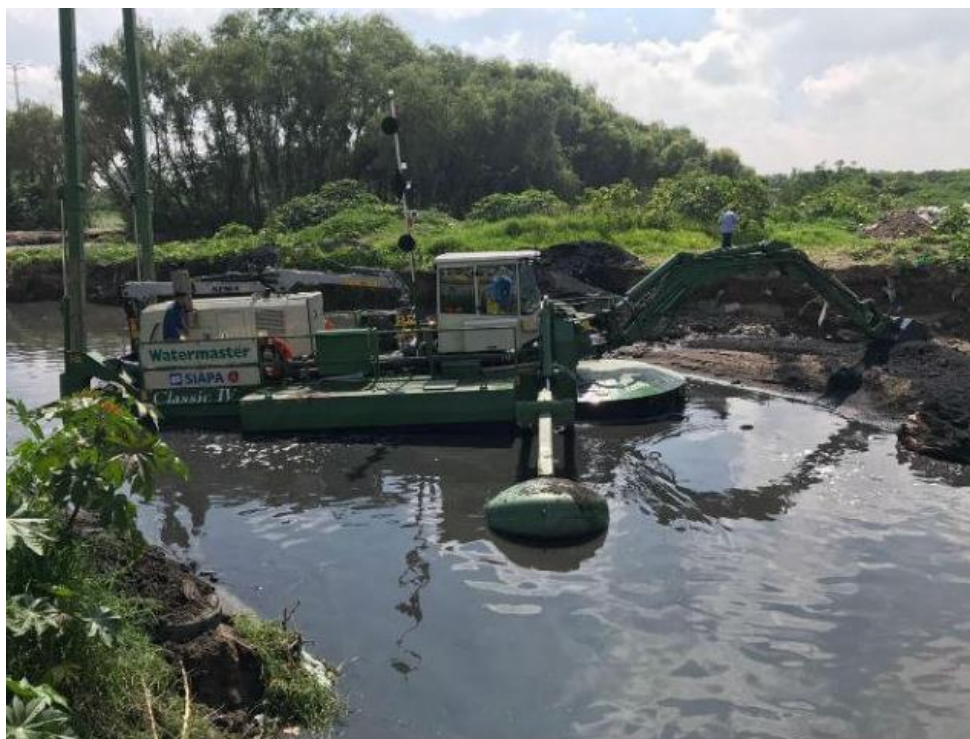
Figura 27. Dragado y desazolve de la presa El Guayabo. Fuente: Informador (2017).
