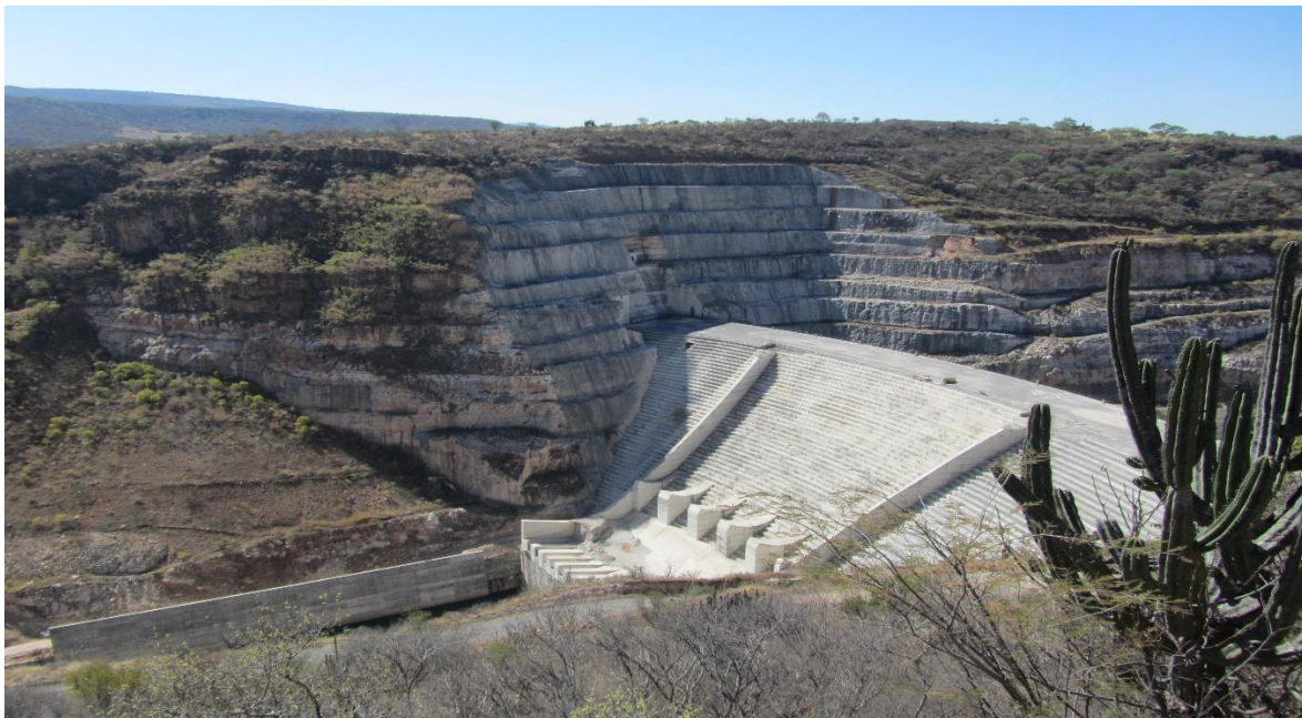
Foto tomada en la visita al área de construcción de la presa El Zapotillo, 02 de marzo de 2019. Loreto Irene Soto Rivas
