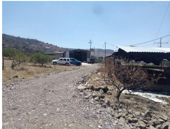
Figura 3. Vista de la planta desde el almacén de materia prima
