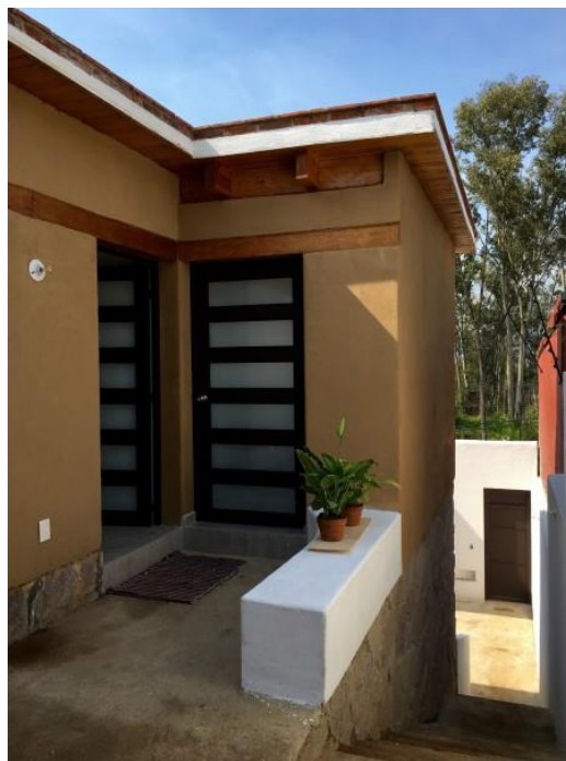
Ilustración 9 Exterior de vivienda de Adobe en Estado de México Fuente: Arq. Nayeli Panduro.
