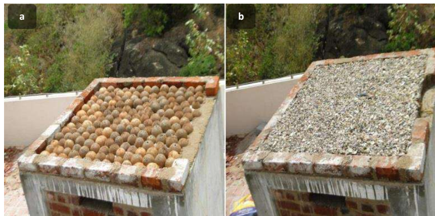
Figura 2.20 Propuesta de aislamiento térmico con coco (a) y conchas marinas (b). Fuente: ( Muralimanohar, et al., 2017 )
