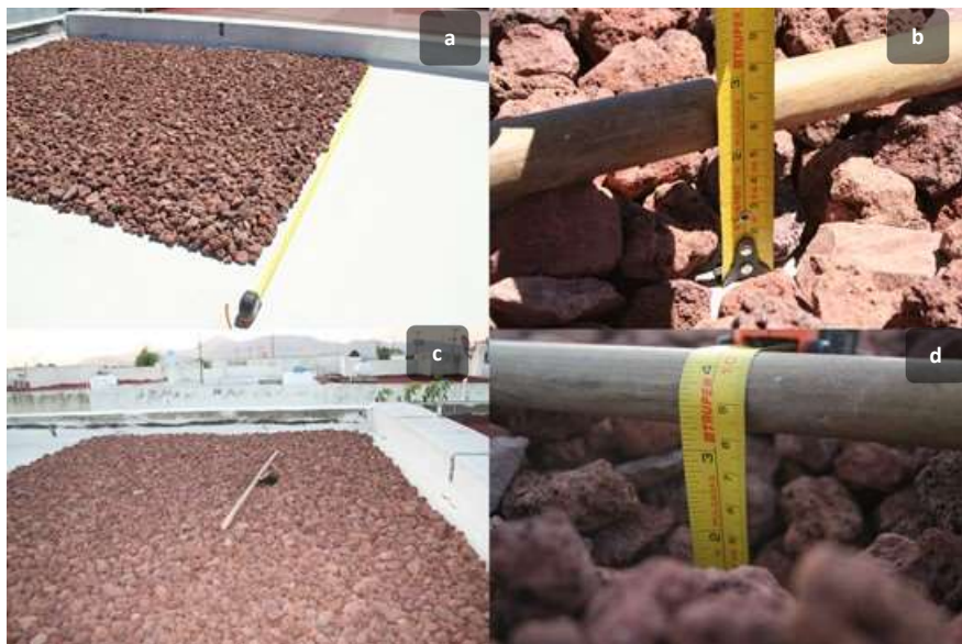
Figura 4.5 Vista de la azotea: a) primera capa; b) medición del espesor de la primera capa de 4.0 cm aprox.; c) segunda capa; d) medición del espesor de la segunda capa de 8.0 cm aprox. Fuente: elaboración propia
