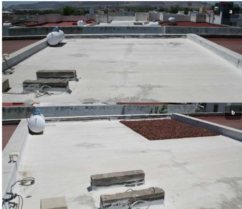
Figura 4.4 Vista de la azotea: a) antes de colocar el tezontle; b) ya colocado sobre la recámara donde se medirán las temperaturas. Fuente: elaboración propia
