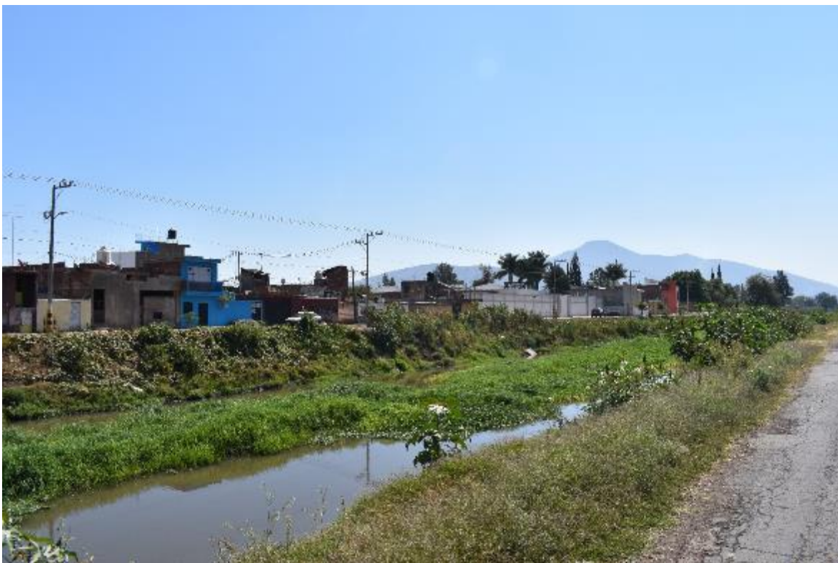
GRAFICO IV-Condicioness actuales del río Duero en su tramo urbano. FUENTE: Francisco Javier Cerda Náñez, Marzo/2019
