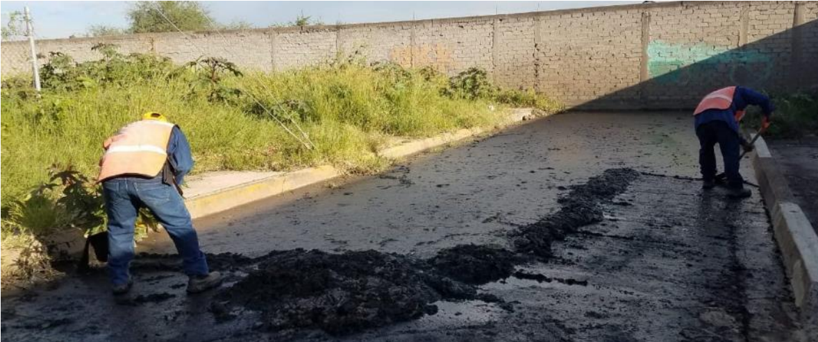
Gráfico 57. El desbordamiento del río Duero de Zamora, Michoacán provoca inundaciones en las colonias del oeste de la ciudad. Fuente: El Sol de Zamora, 05 de agosto de 2019.
