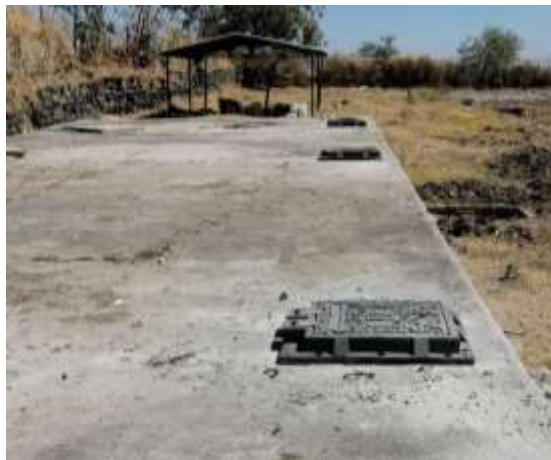
Figura 29. Nuevas tapas instaladas en el tanque séptico (Fuente: Archivo fotográfico del proyecto de rehabilitación).
