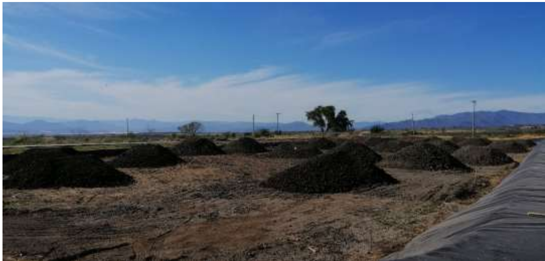
Figura 26. Nuevo material añadido al relleno del humedal (Fuente: Archivo fotográfico del proyecto de rehabilitación).
