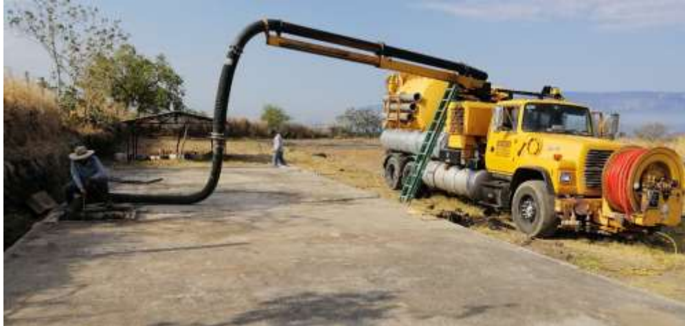
Figura 28. Trabajos de desazolve del tanque séptico (Fuente: Archivo fotográfico del proyecto de rehabilitación).
