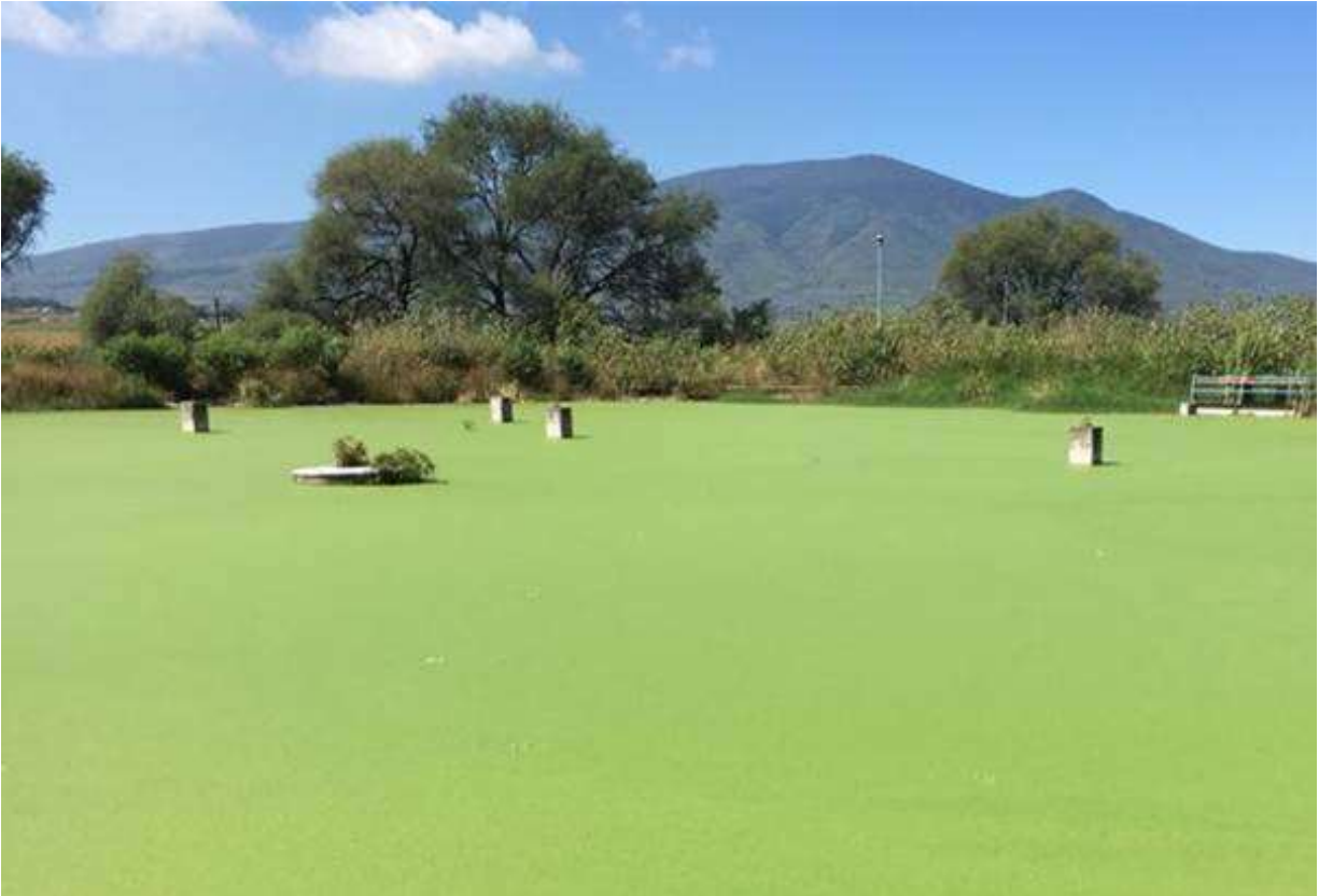
Figura 4. Laguna de aireación de la PTARM de Poncitlán en estado de abandono (Fuente: Tomada por Víctor M. Mijangos Pulido, 2018. Publicada con autorización de CIATEJ).
