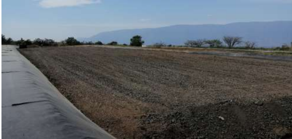
Figura 27. Nivelación del material añadido en el humedal (Fuente: Archivo fotográfico del proyecto de rehabilitación).
