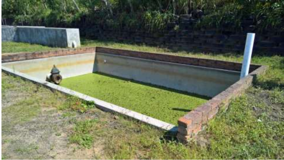
Figura 18. Fosa de lodos de la unidad de pretratamiento (Fuente: Archivo fotográfico de visitas al sitio).
