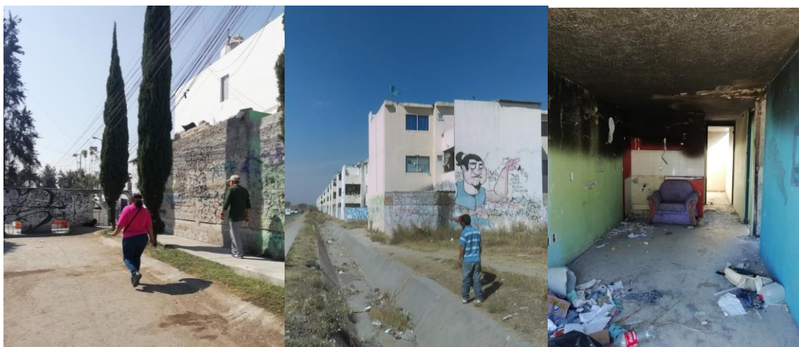
65. Puertita, calle sin iluminación y vivienda abandonada. Fotografía Tania Chávez.
