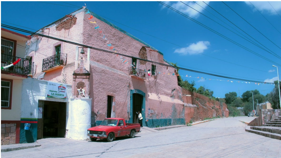
Figura 7.14. Ciudad de Zacatecas, Zacatecas, 2017, Hacienda del Barrio de la Pinta, Calle Miguel A. Chávez. Pablo Vázquez Piombo, 2017.
