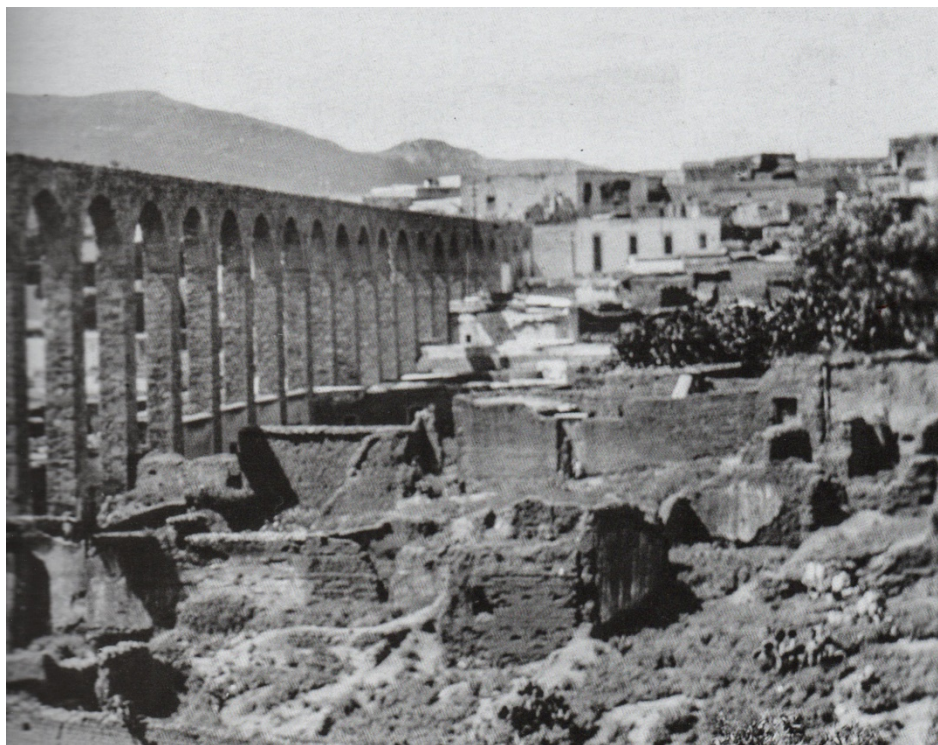
Figura 6.18. Ciudad de Zacatecas, al sur, vista del antiguo acueducto, mediados del siglo XX, S/F. Se observa la ciudad en ruinas, parcialmente abandonada. Fototeca de Zacatecas P. Valtierra Cat. 99 ( Imagen y Memoria, Un álbum familiar de Zacatecas , 2010, pp. 128–129)
