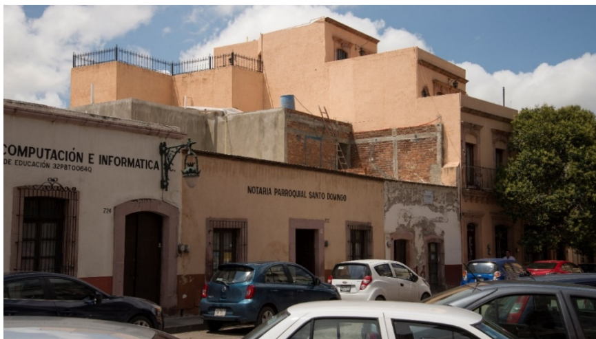
Figura 6.23. Ciudad de Zacatecas, Zacatecas, 2018. Inmueble privado, calle Genaro Codina. Su intervención es resultado de un estudio sobre la fachada principal, con el propósito de escalar los niveles superiores autorizados para ser metidos respecto al primer paramento. Es evidente en esta imagen que no se previó el resultado en las fachadas laterales, ya que el impacto dentro del contexto es negativo y presenta una afectación considerable. Pablo Vázquez Piombo, 2018.
