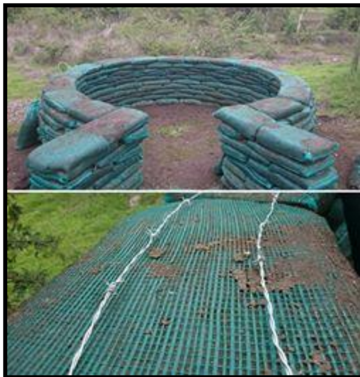
Ilustración 12 Técnica de Sacos de Tierra
