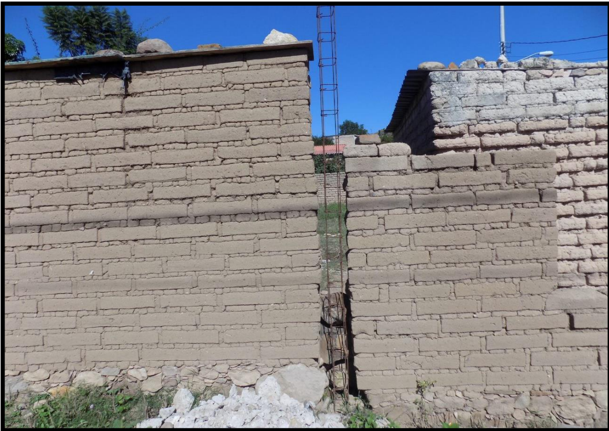
Ilustración 14 Implementación de castillo en muro de adobe
