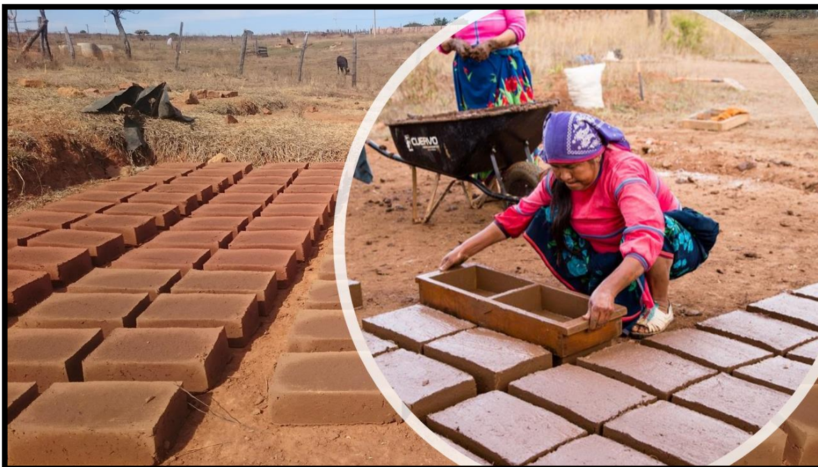
Ilustración 7 Adobes fabricados en la comunidad de San Andrés en la brigada solidaria de verano de Tu Techo 2019
