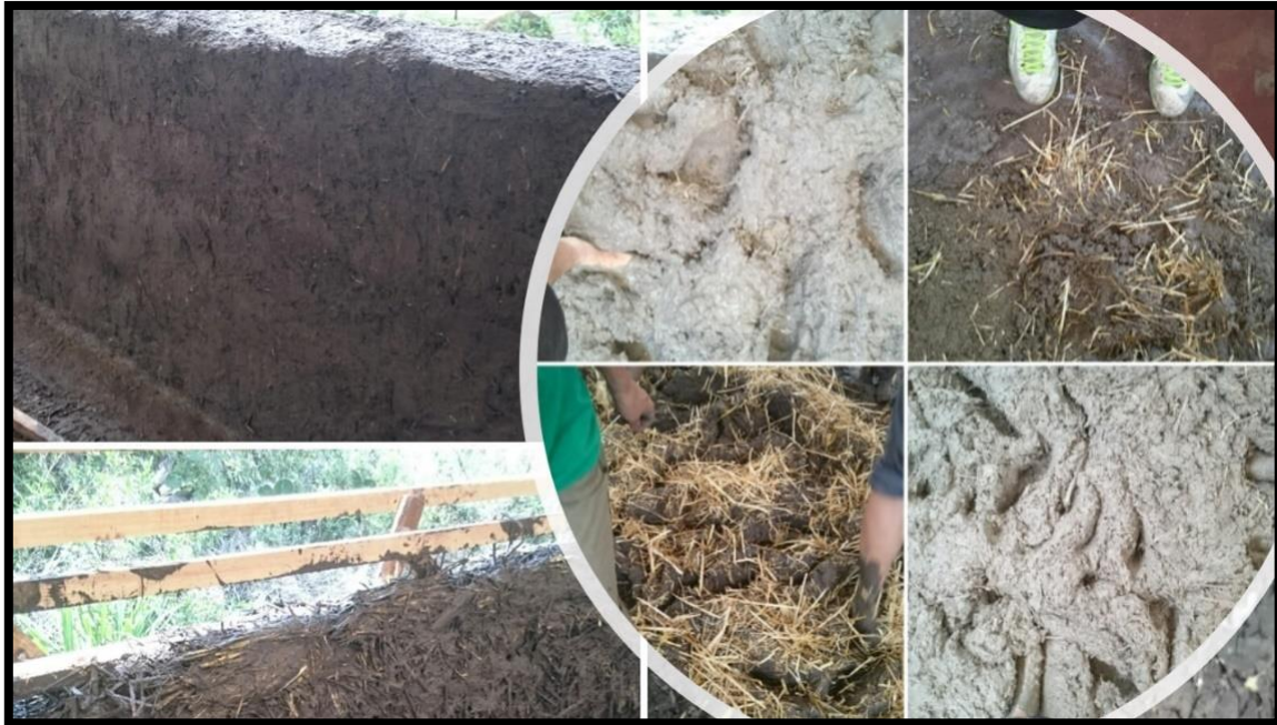
Ilustración 8 Mezcla y aplicación del Bahareque
