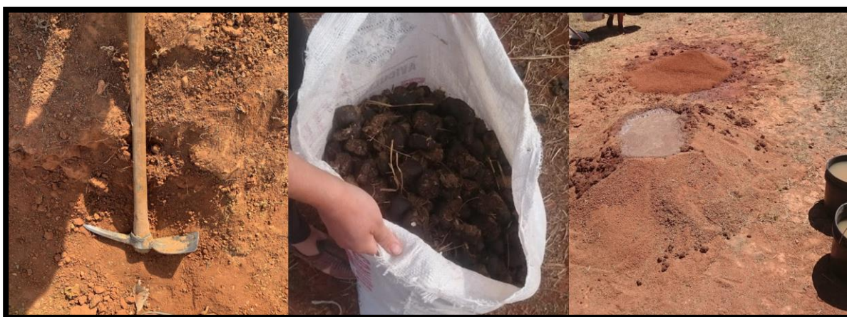
Ilustración 6 Tierra, Estiércol, Agua y volcán de mezcla
