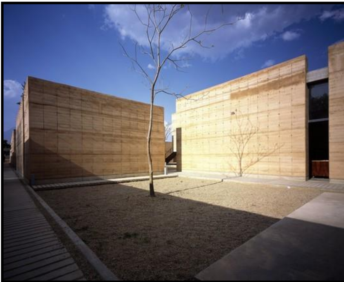
Ilustración 13 Escuela de Artes plásticas con 15 % de cemento, Foto de Sandra Pereznieto
