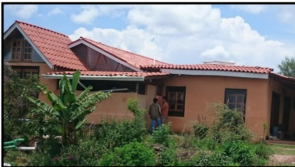
Ilustración 10 Casa construida utilizando la técnica de Cob
