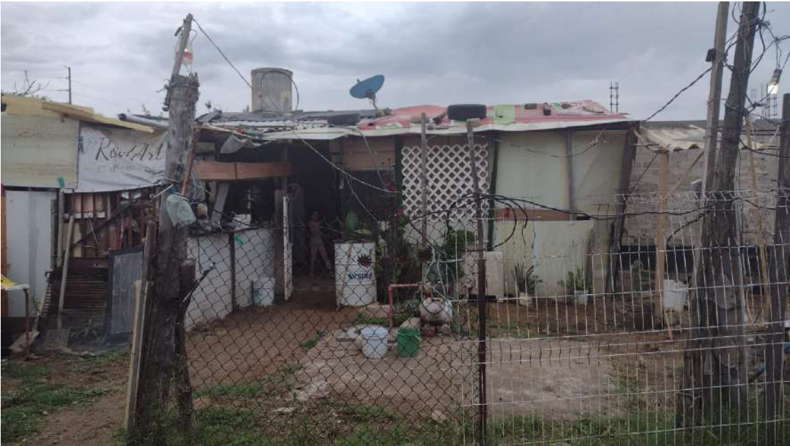
Figura 25: Fotografía de vivienda en cooperativa Nextipac. Fuente: Ángeles Ortiz (2021).
