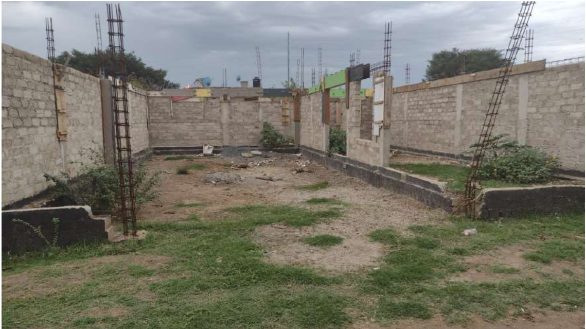
Figura 24: Fotografía de construcción en cooperativa Nextipac. Fuente: Ángeles Ortiz (2021).
