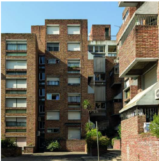
Figura 16: Vista frontal Cooperativa de Viviendas de Funcionarios de Impositiva. Fuente: Nómada (2015).
