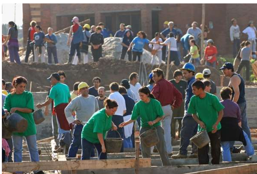
Figura 8: Socios en proceso de construcción de viviendas. Fuente: FUCVAM (2019).
