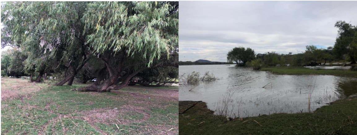
*Imagen tomada por el equipo. Presa el Tecuán.
