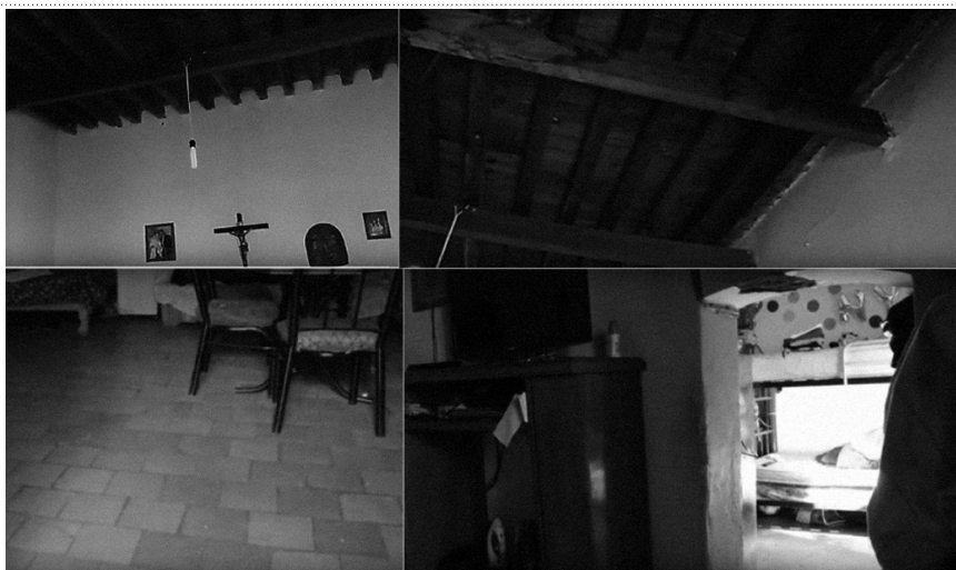
FIGURA 3.6 DISTINTAS VISTAS DEL INTERIOR DE LA CASA HABITACIÓN MEJOR CONSERVADA, CON SU TECHUMBRE Y PISO ORIGINAL
