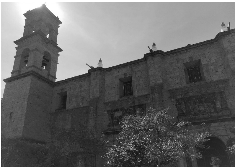
FIGURA 4.8 VISTA EXTERIOR DEL TEMPLO DE SANTA TERESA EN GUADALAJARA
