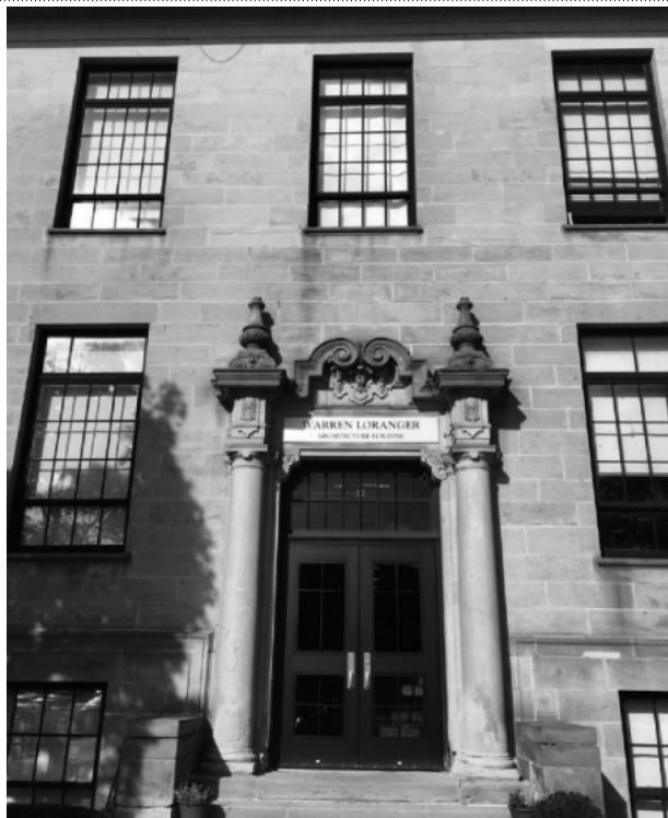
FIGURA 5.1 EDIFICIO WARREN LORANGER (FACHADA SUR). UNIVERSIDAD DE DETROIT MERCY
