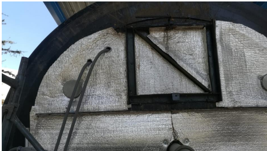
Figura 27. Entradas adicionales para las sondas de muestreo en la cara del tanque
