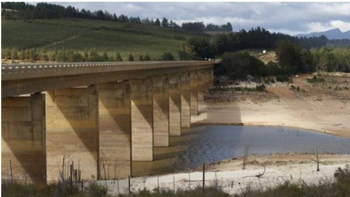
Figura 1-1 Presa de Theewaterskloof, Ciudad del Cabo
