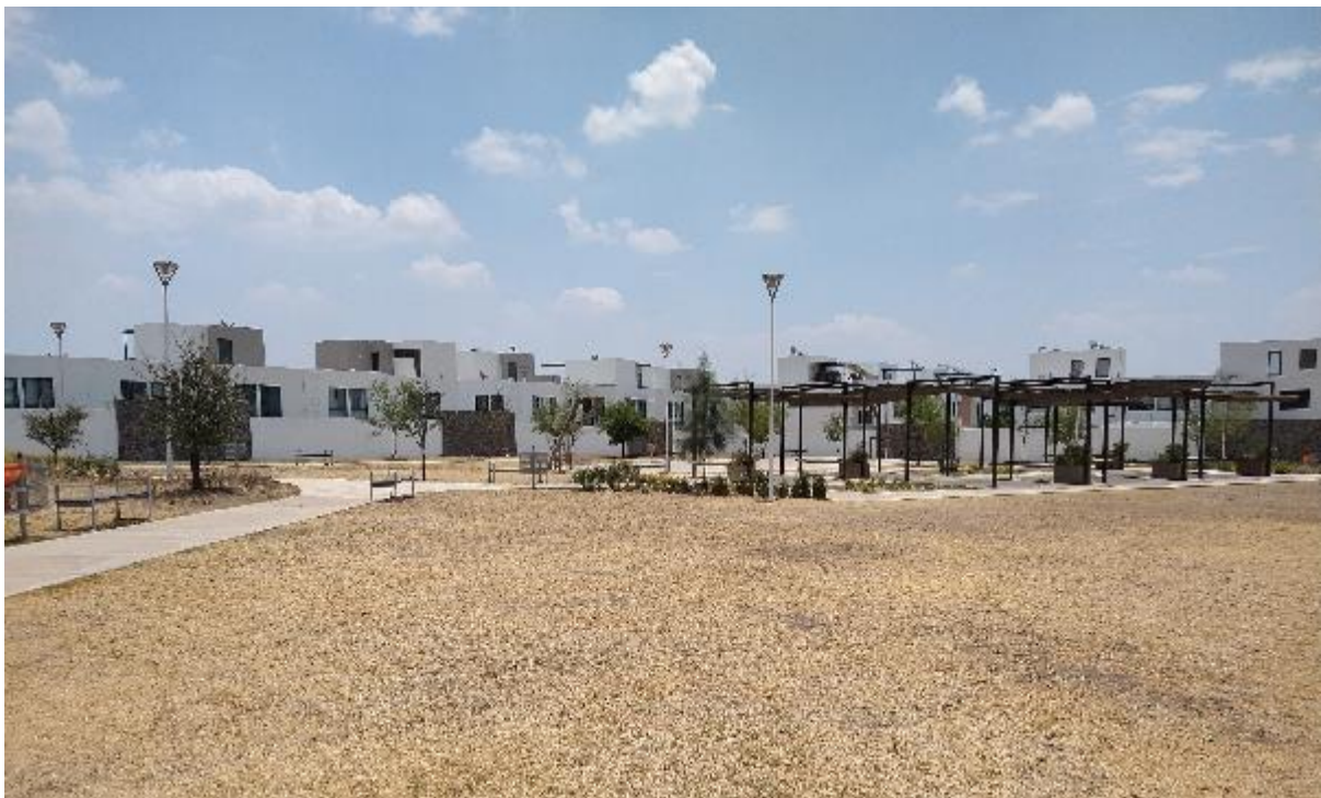
Figura 5-5 Áreas ajardinadas secas por falta de riego.
