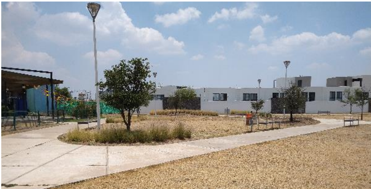
Figura 5-8 Andadores con pavimento hidráulico, áreas verdes secas.
