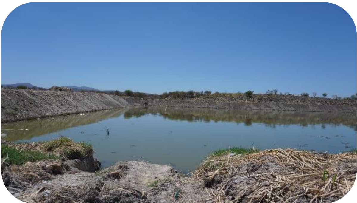
Figura 3-11 Vaso regulador en condiciones contaminados, se percibe olor a basura y agua en descomposición. Municipio de Tlajomulco.
