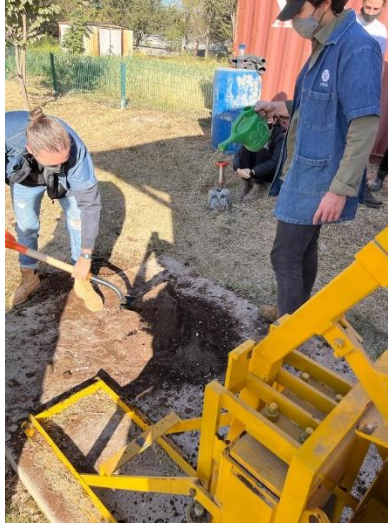
REALIZACIÓN DE LA MEZCLA PARA BTC.
