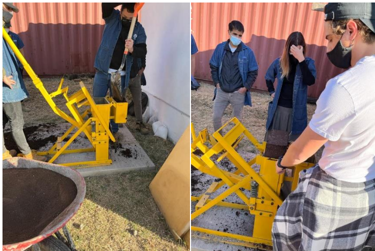
LLENADO DE LA MÁQUINA CON LA MEZCLA Y OBTENCIÓN DE BTC.
