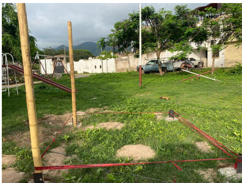
Ilustración 87. Proceso de colocación de columnas de bambú 2022.
