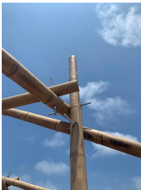
Ilustración 48. Imagen de las conexiones de las piezas de bambú 2022
