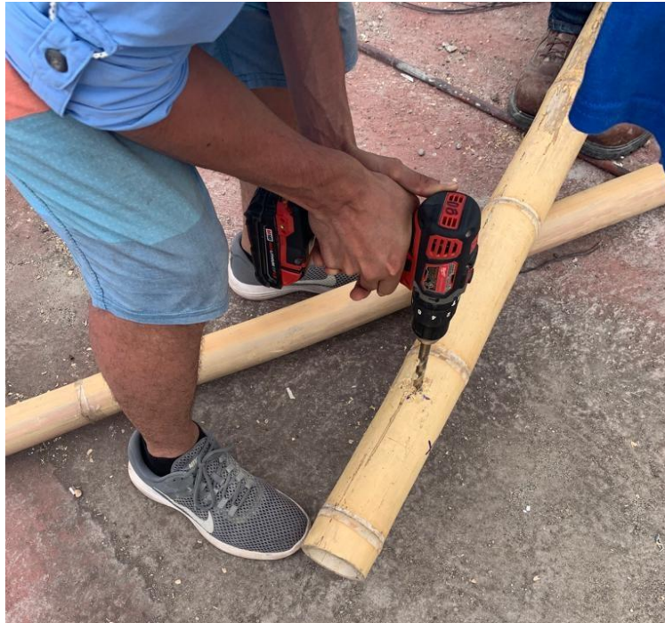
Ilustración 49. Imagen de la perforación en bambú para las conexiones 2022
