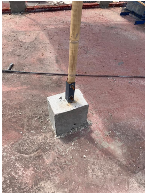
Ilustración 35. Dado de cimentación. Cubierta en azotea.
