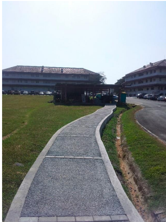
Ilustración 95. Concreto Permeable, ciclovía Panamá. (NRMCA 2020)
