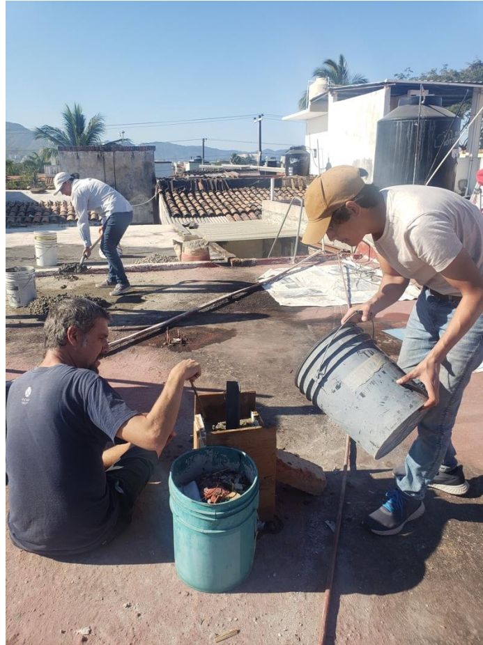
Ilustración 14. Colado de dados en azotea para cubierta de bambú.
