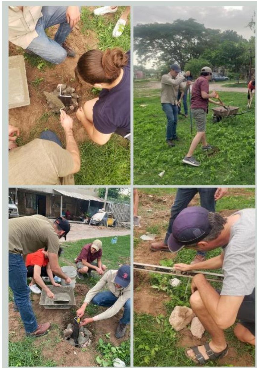
Ilustración 85. Proceso de colado y excavación de zapatas de cubierta. (Elaboración propia 2022)
