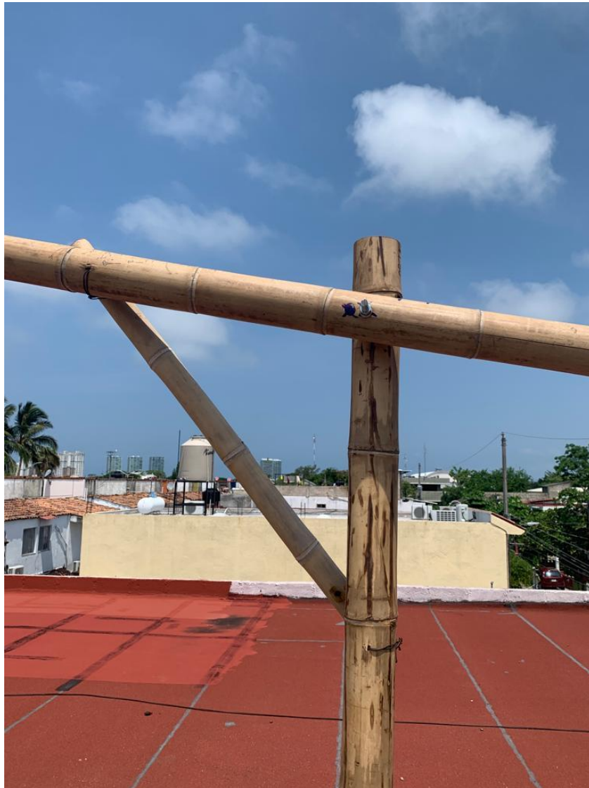
Ilustración 46. Imagen de las conexiones trabe – columna.2022
