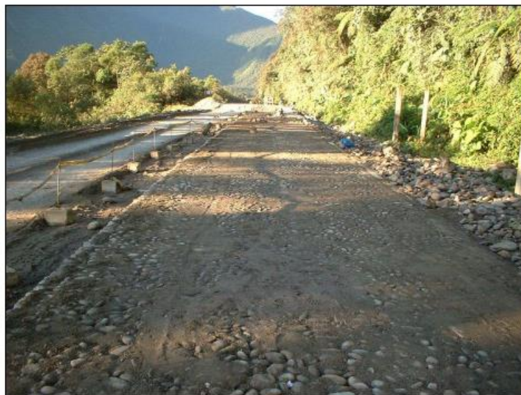
Ilustración 97. Vista de construcción de vialidad con empedrado. (Godoy 2004)
