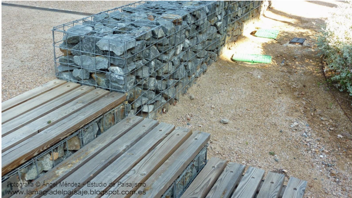
Ilustración 9. Detalle de protección de predio con gaviones. (Foto de Ángel Méndez, estudio paisajismo 2020.)
