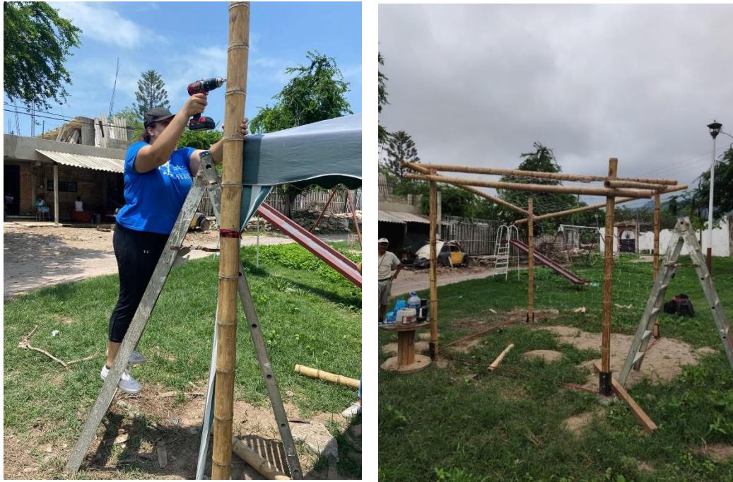
Ilustración 90. Proceso de perforación de culmo de bambú y cubierta terminada 2022.
