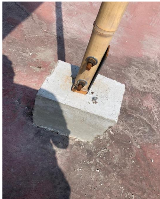
Ilustración 41. Dado de cimentación realizado en Primavera 2022.
