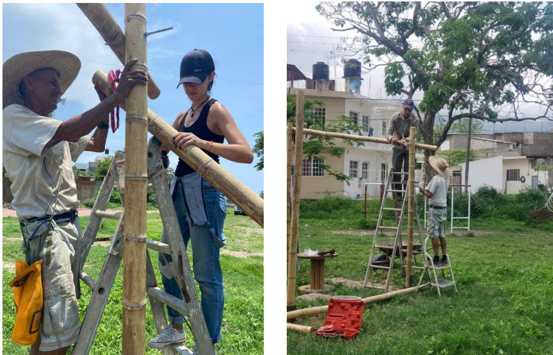
Ilustración 89. Construcción de cubierta con locales del parque 2022.
