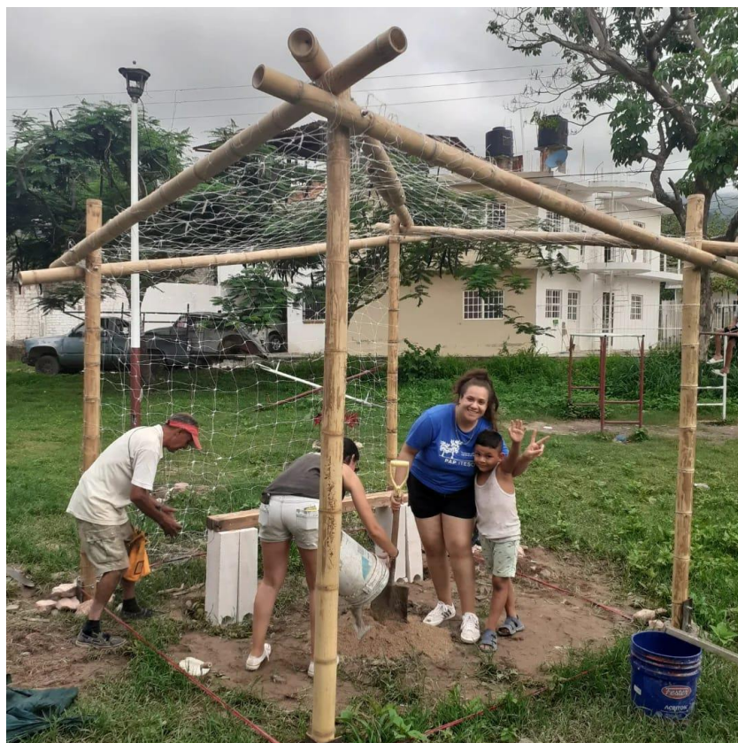
Ilustración 93. Trabajo en cubierta de bambú con locales, construcción de banca 2022.
