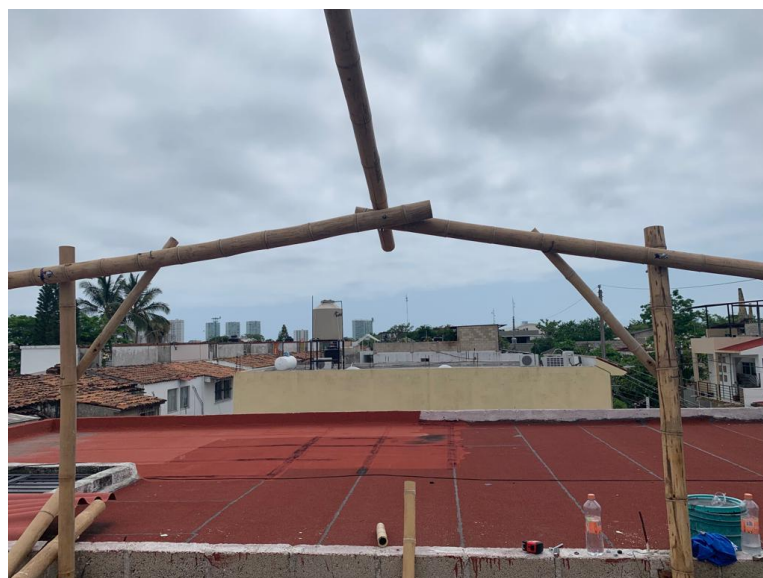
Ilustración 45. Imagen de la colocación de la estructura para cubierta de bambú 2022
