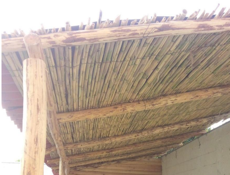
Ilustración 51. Ejemplo de carrizo en cubierta/2022
