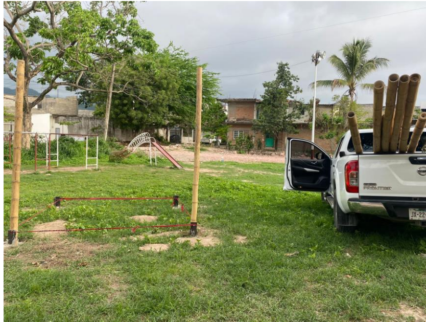
Ilustración 88. Traslado y armado de primera etapa de cubierta de bambú, 2022.
