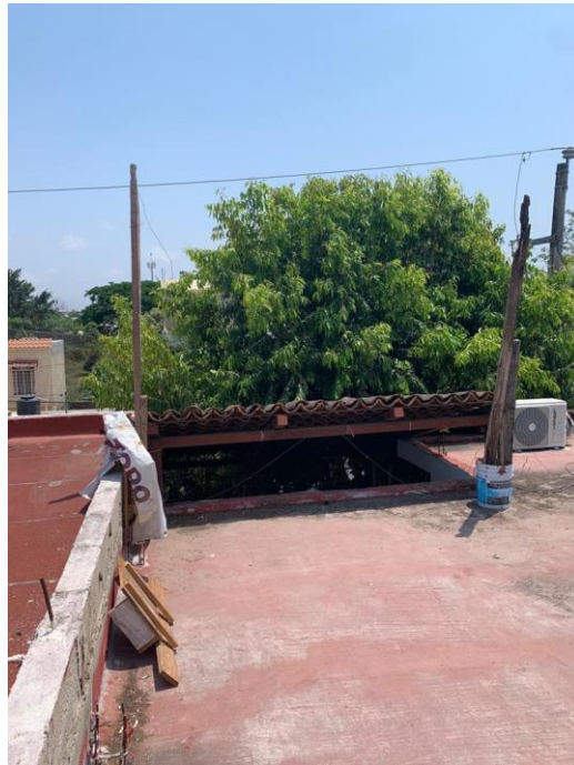
Ilustración 42. Estado actual de la azotea.2022
