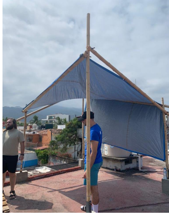
Ilustración 34. Colocación de cubierta en azotea.
