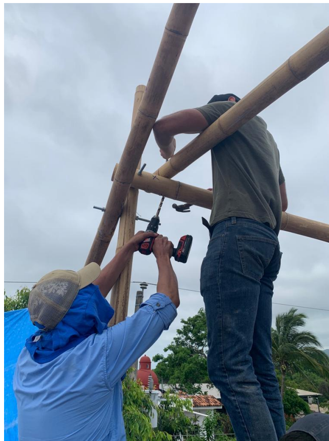
Ilustración 50. Imagen de la perforación en bambú para las conexiones 2022
