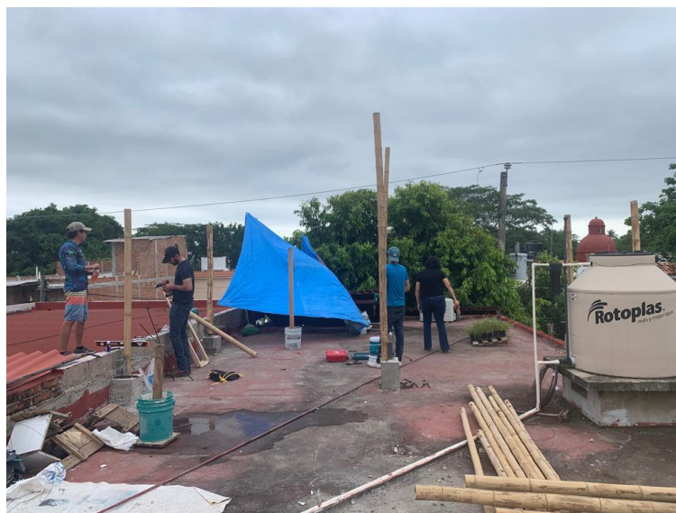
Ilustración 43. Imagen de la colocación de las columnas de bambú 2022
