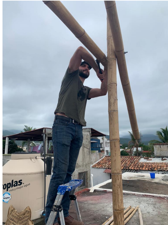
Ilustración 44. Imagen de la colocación de las traves de bambú 2022
