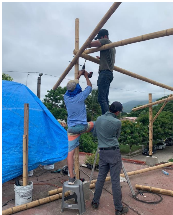
Ilustración 47. Imagen de cómo se hicieron las conexiones de las piezas de bambú 2022
