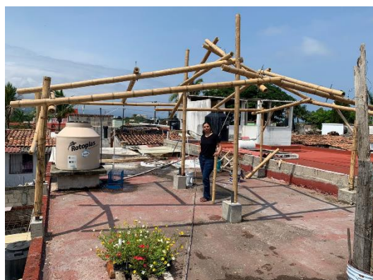
Ilustración 23. Imagen de la estructura terminada en el verano 2022.
