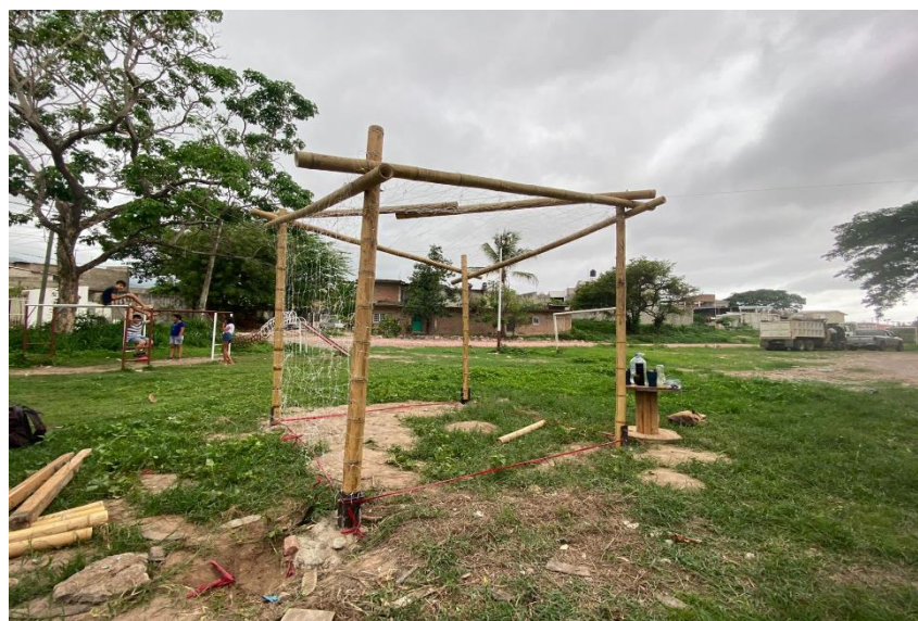
Ilustración 92. Cubierta terminada con malla para enredaderas 2022.
