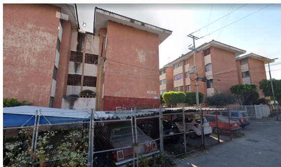
IMAGEN 33- Ausencia de mantenimiento urbano y de la vivienda en la Unidad habitacional Cuauhtémoc, Guadalajara, jal.
