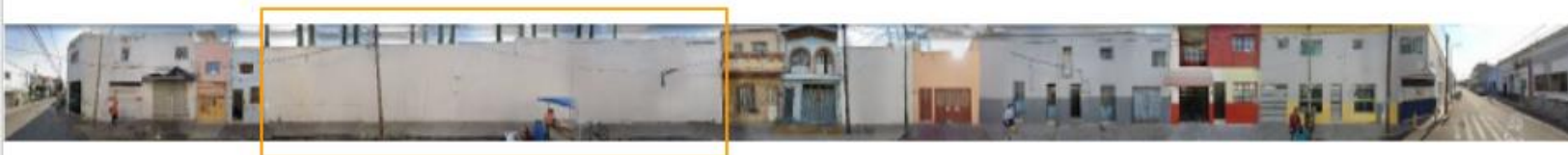
Vista Calle Analco, fachada poniente Predio
