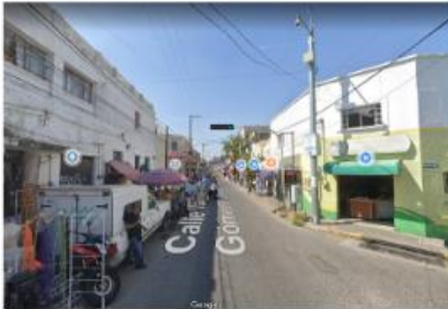
3.- Gómez Farías, vista de fachada norte del predio
