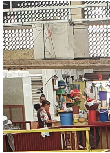
Tinacos de agua encima del muro en planta alta. Elaboración propia
