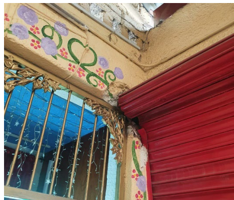
Perforación de columna y trabe para espacio de cortina. Elaboración propia
