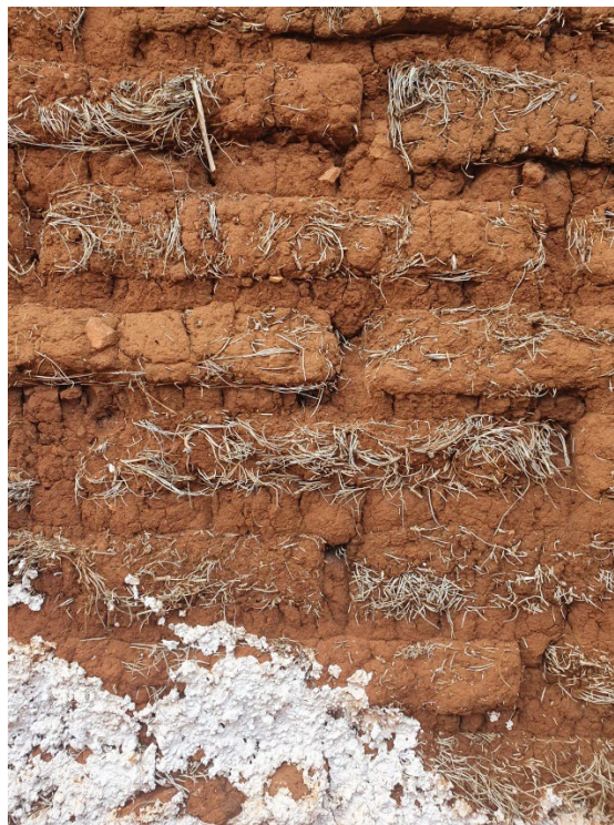
Imagen de un muro de adobe con fibras de ocochal de una vivienda típica de la región. (Elaboración Propia)
