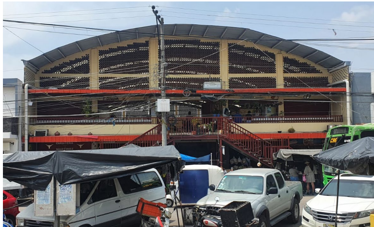
Fachada principal de Mercado Juárez. Elaboración propia
