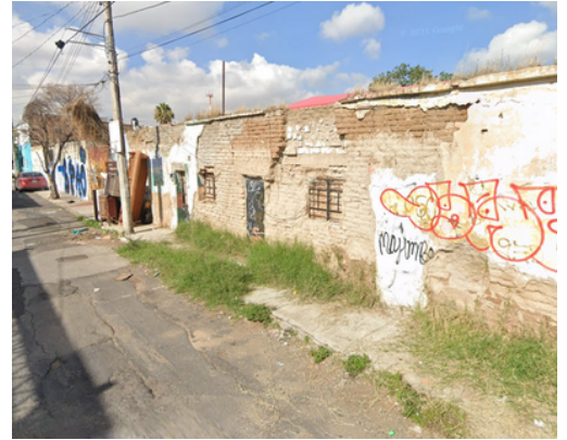
Ubicado en una zona con calle, fachadas e infraestructura descuidadas
