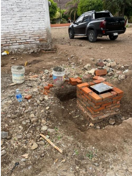
Imagen 6: Terminado de Cimentación de ladrillo de mampostería.
