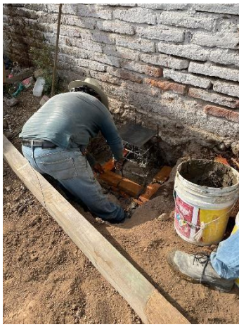
Imagen 3 Don Cecilio Armado de Hiladas Cimbra.
