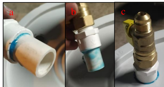
Figura 17. Aplicación del pegamento PVC en adaptador macho para válvula de gas con tubo PVC 1/2" (a), tubo PVC de válvula de gas para pegar con la tapa (b) y la válvula pegada a la tapa (c).
