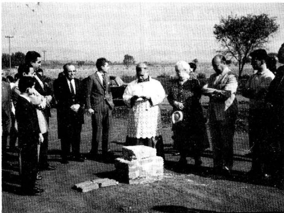
El Exmo. Sr. Francisco Javier Nuño bendiciendo la primera piedra del Edificio A. Lo acompañan el P. Jorge Villalobos y doña Clarisa Prieto de Hernández.
