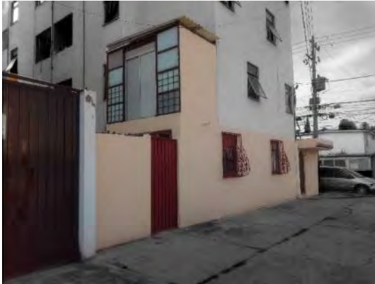
Figura 4-3. Apropiación en construcciones añadidas.
