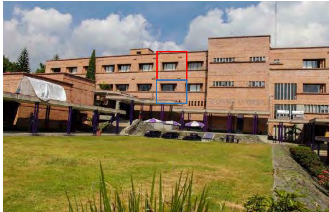
Figura 58-4. Fotografía de muro sur del edificio donde se encuentra la oficina de estudio.
