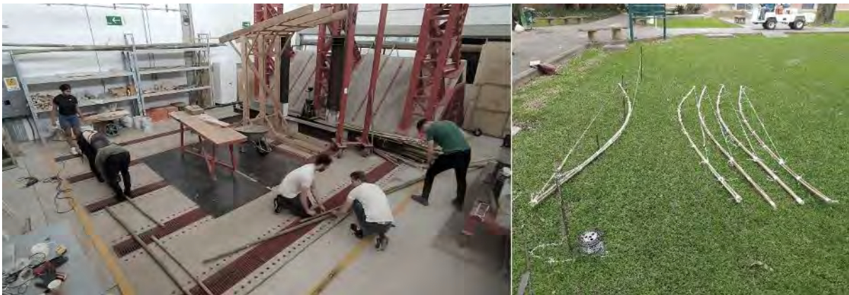
Figura 56-3. Proceso de ejecución de arcos de sección compuesta.
