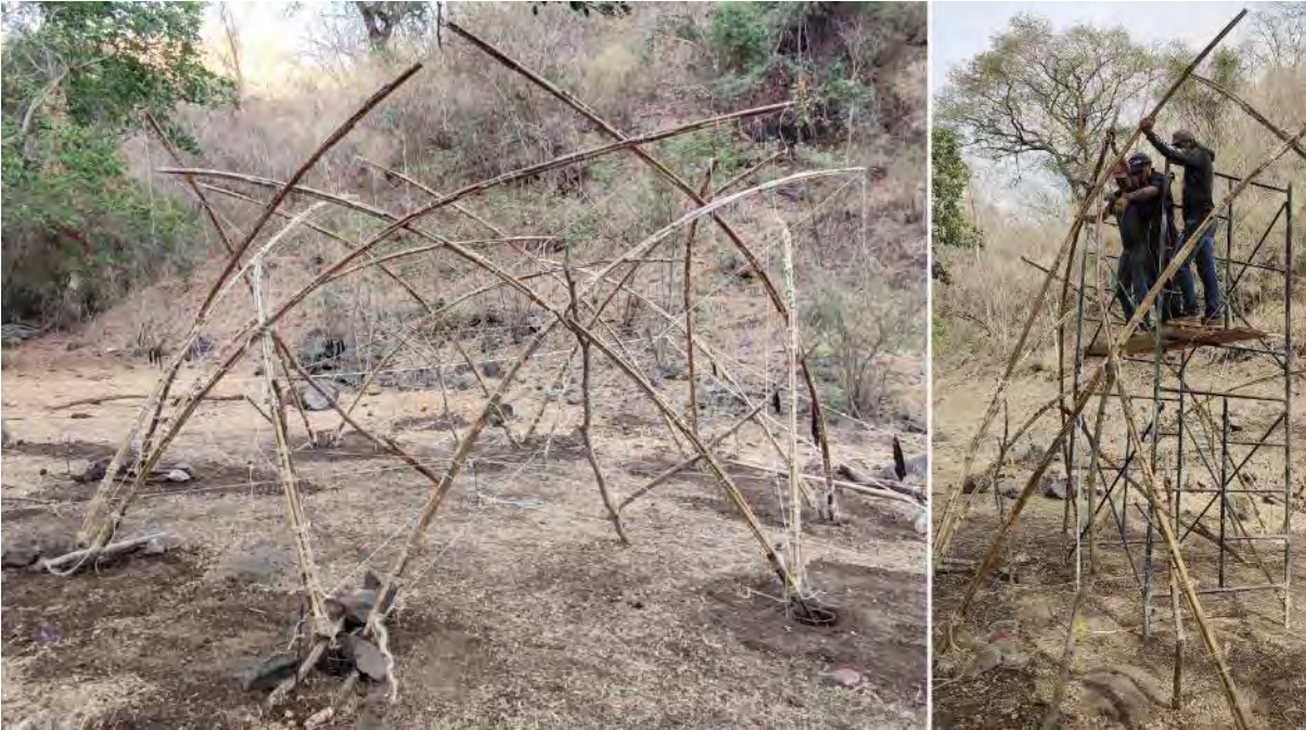
Figura 56-4. Proceso de instalación de la estructura.
