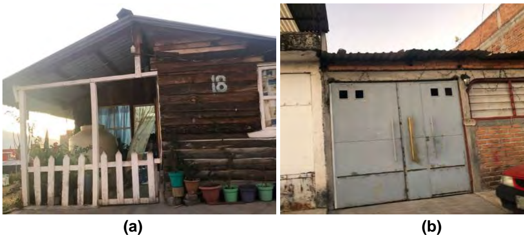
Figura 57-2. Vivienda autoconstruida en la colonia Ignacio López Rayón en Morelia, Michoacán: (a) cubierta ligera con lámina metálica y sistema vertical constructivo de mampostería, (b) cubierta ligera de lámina metálica con sistema vertical constructivo de madera.
