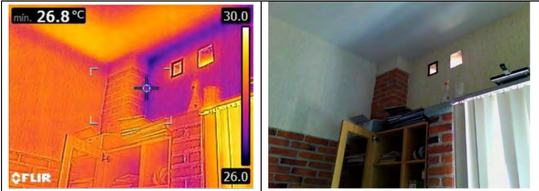
Losa de azotea en interior de oficina de estudio 12:00 p.m.
