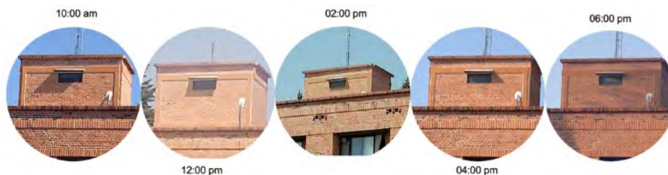
Figura 58-4. Reporte fotográfico de sombreado en muro sur del edificio donde se encuentra la oficina de estudio.
