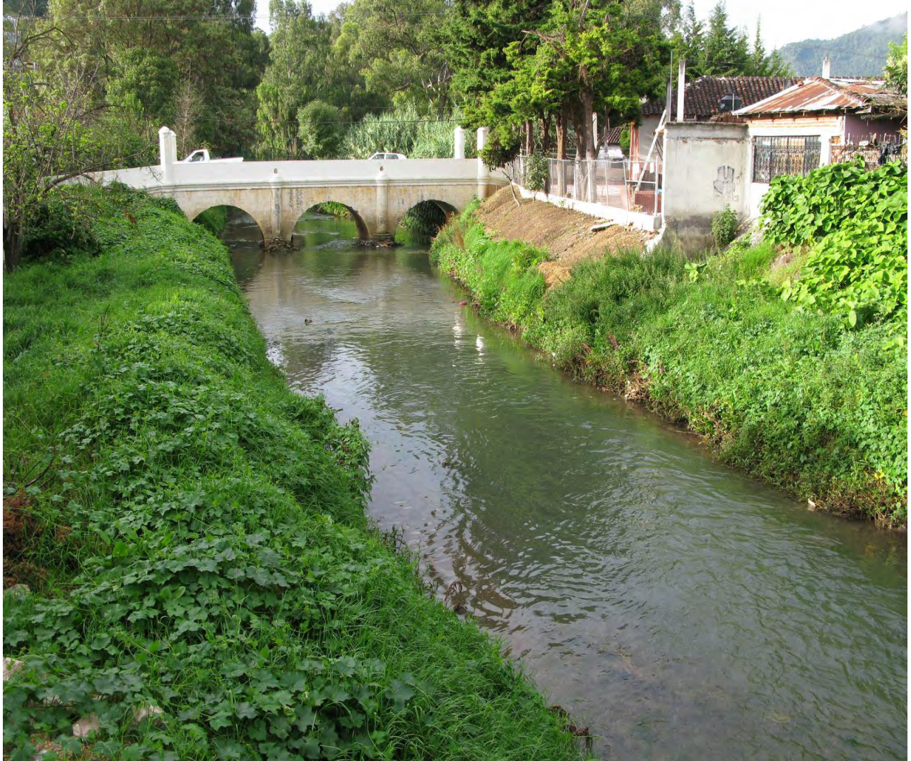
El Puente Blanco San Cristóbal de Las Casas, Chiapas
