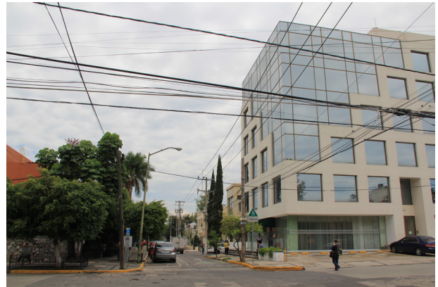
Imagen 49. Cuadra 2. Un único uso en un edificio de más de dos niveles provoca soledad e inseguridad durante fines de semana.
