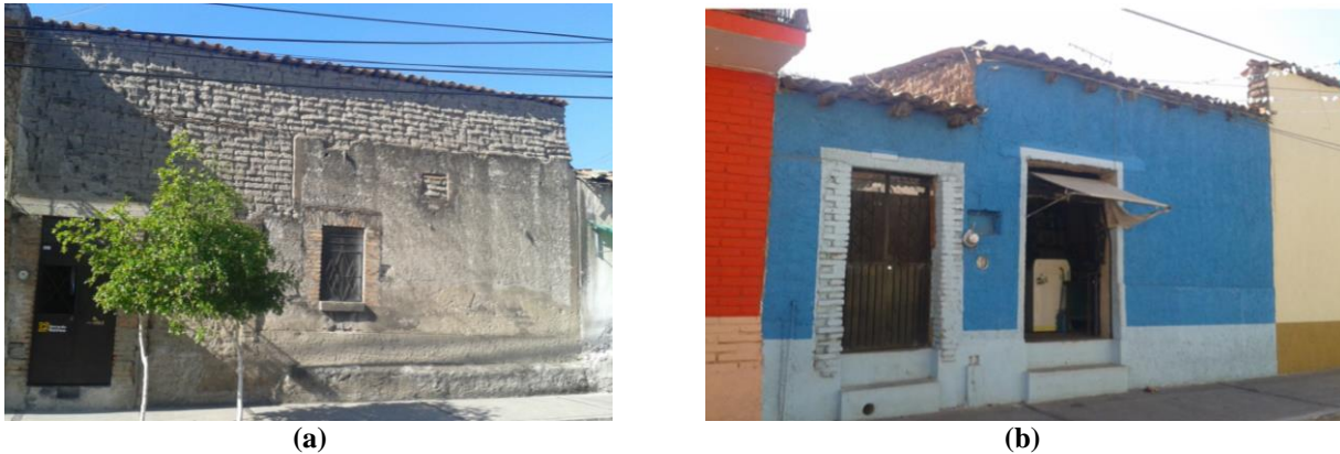
Figura 7 Viviendas típicas de adobe tradicional. (a) adobe aparente con doble altura y (b) adobe con aplanado y pintura
