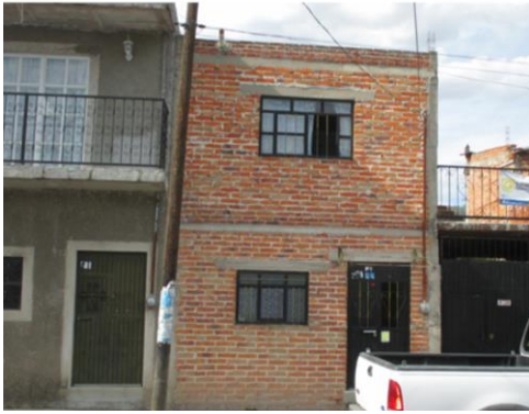
Figura 9 Viviendas típicas de tabique de barro rojo con confinamiento ineficiente o sin diseño sísmico
