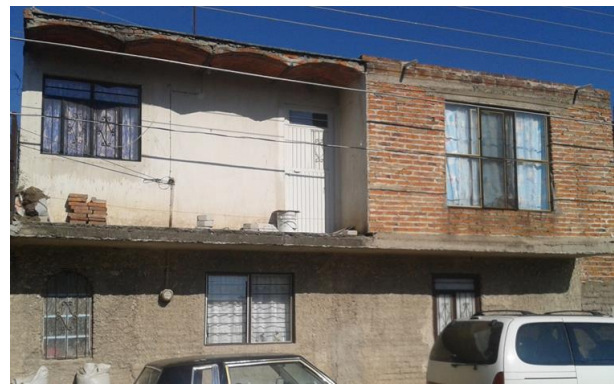
Figura 10 Viviendas típicas de tabique de barro rojo recocido sin confinamiento
