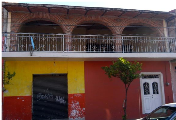
Figura 10 Viviendas típicas de tabique de barro rojo recocido sin confinamiento
