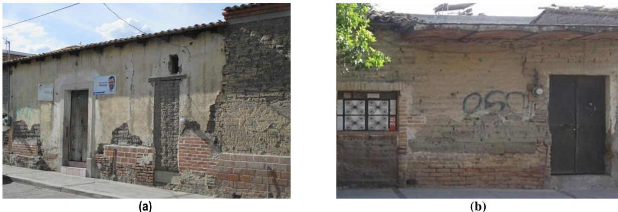
Figura 8 Viviendas típicas de adobe combinado con tabique de barro rojo recocido. (a) Con cubierta ligera y (b) con cubierta abovedada de mampostería de tabique de barro y perfil de acero
