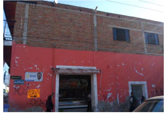
Figura 9 Viviendas típicas de tabique de barro rojo con confinamiento ineficiente o sin diseño sísmico
