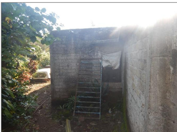
Imagen 15. Fachada con orientación al Oeste.
