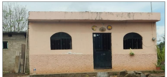
Imagen 11. Vivienda rural de Benito Juárez, fachada sur. Fuente: Propia.
