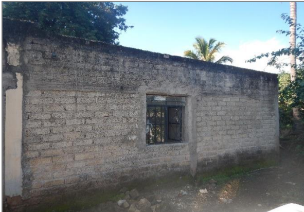
Imagen 14. Fachada con orientación al Norte.
