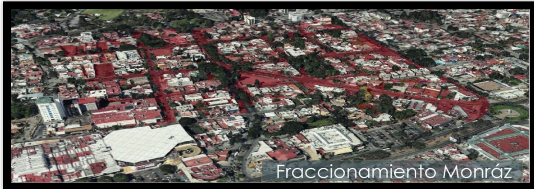
Imagen 1. "Vista Aérea", Sociedad de Colono del Fraccionamiento Monraz A.C.
