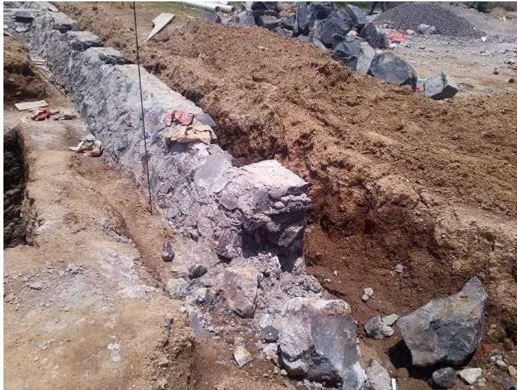
Cimentación corrida a base de piedra braza
