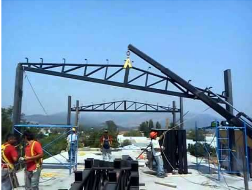
Figura 10. Montaje de armadura metálica utilizando una grúa
