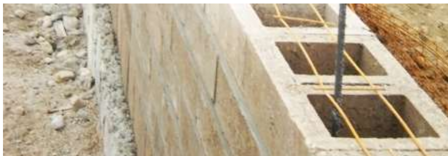
Varilla para muro de block hueco
