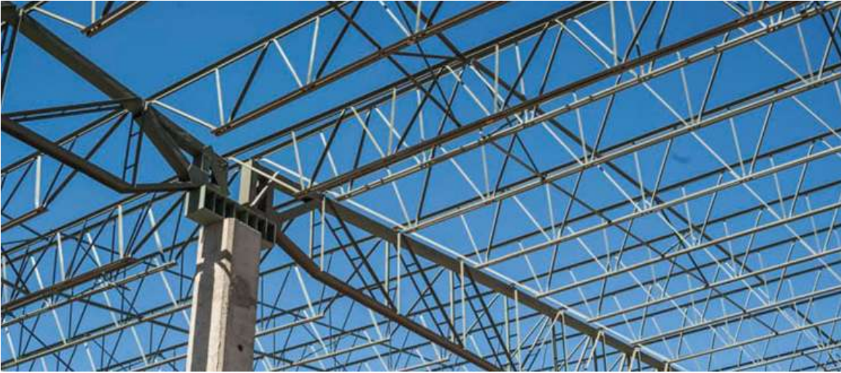
Figura 9. Joist siendo soportados por armaduras metálicas. Fuente: Arquitectura + acero
