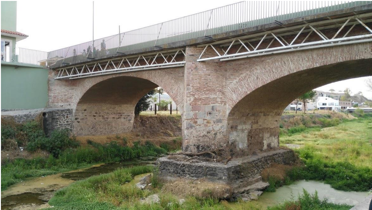
FOTO 25. Deberá proponerse alternativas para eliminar las estructuras adyacentes a los puentes patrimoniales. Jalostotitlán, autoría propia
