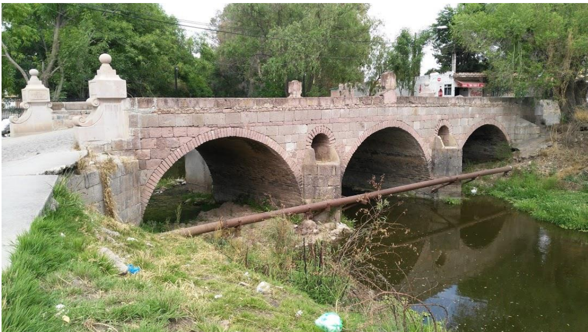
FOTO 17. Puente Corregidora, San Miguel el Alto. Autoría propia.
