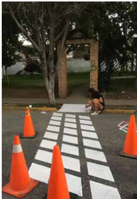
Primer mitad del paso Peatonal c cobre
