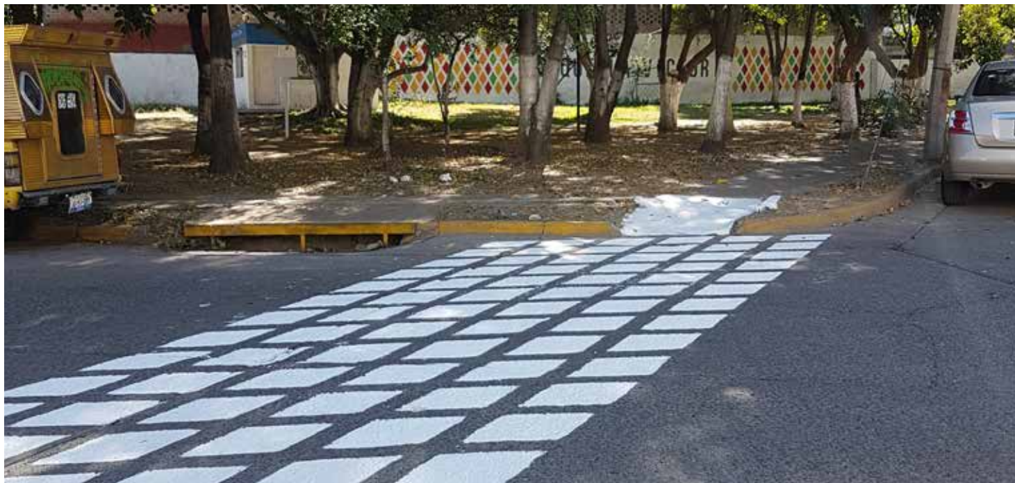
Paso peatonal calle cobre, terminado
