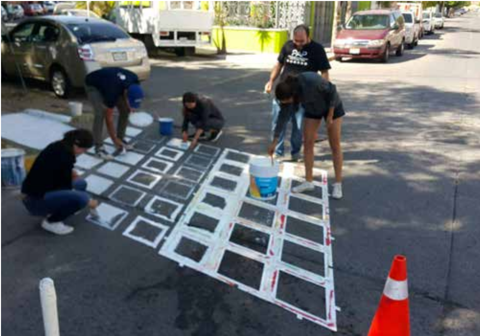
Paso peatonal sobre av ahuehuetes
