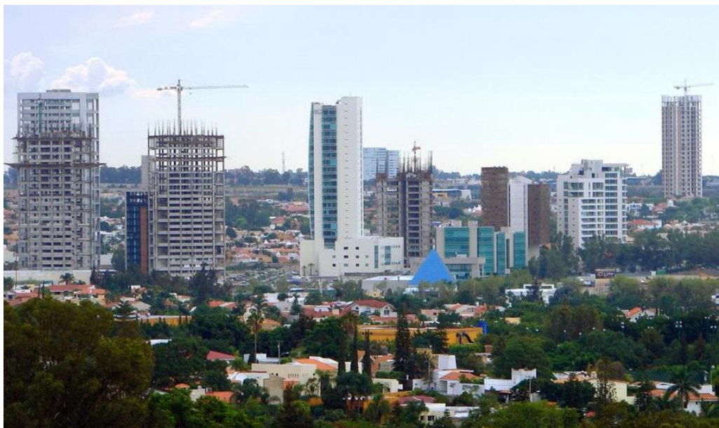
Figura 2 Vista general de edificios típicos construidos en la AMG
